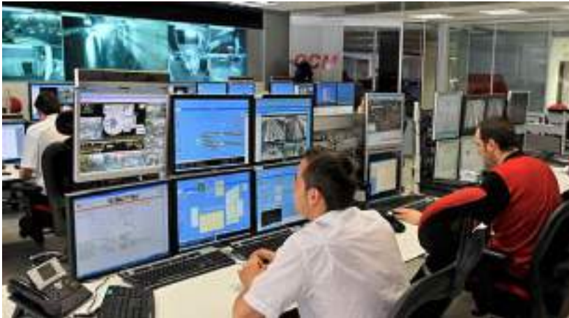
Centre de control Metro de TMB. Font: TMB
