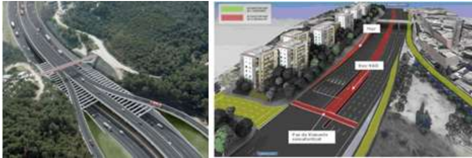
BUS-VAO en construcció (C-58) Av. Meridiana - Ripollet
