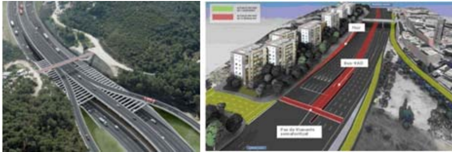
BUS-VAO en construcció (C-58) Av. Meridiana - Ripollet
