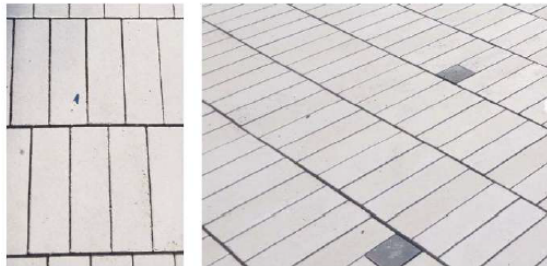
PEÇA PREFABRICADA DE FORMIGÓ 10X30, COLOR "CANOPIA"
