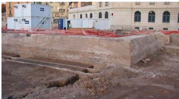
Vista general de les restes arqueològiques del Baluard de Migdia Fotografia: MHCB - Mikel Soberón
