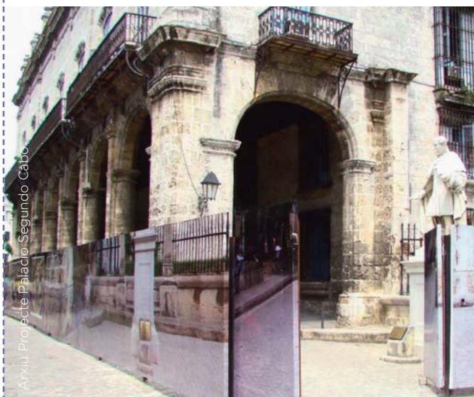
Palau Segundo Cabo en rehabilitació (2010)
