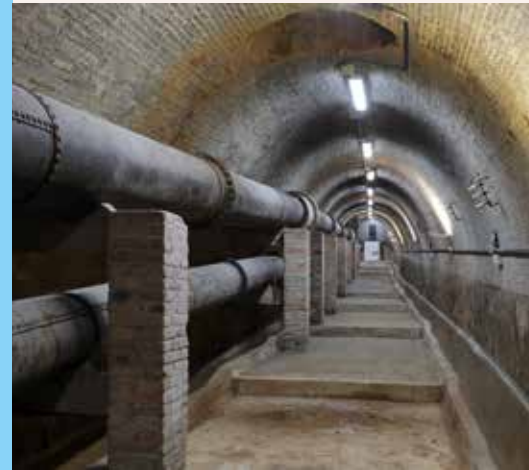
Interior del túnel que connecta les cases de Trinitat Vella i Trinitat Nova. © MUHBA / Manuel Cohen
