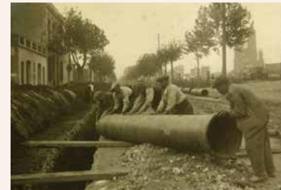
Col·locació de canonades de conducció d'aigua als voltants de la Sagrada Família, 1917. Arxiu MUHBA
