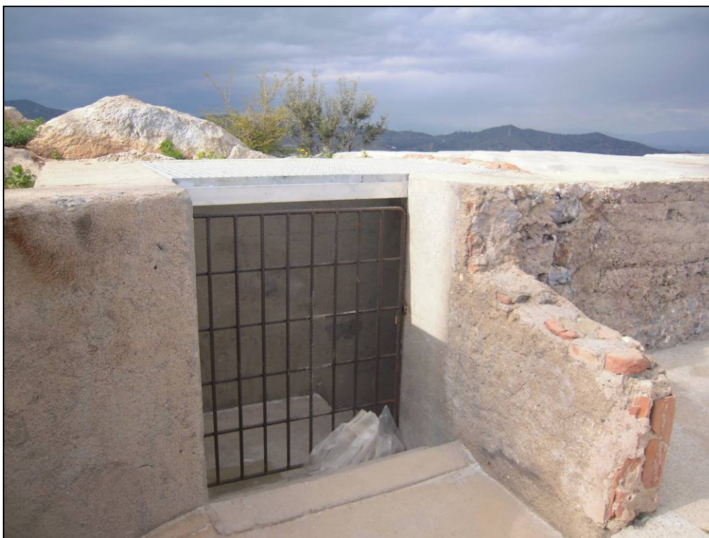
Foto 30: Col·locació d'una porta per a la protecció dels espais interiors de la bateria antiaèria.
