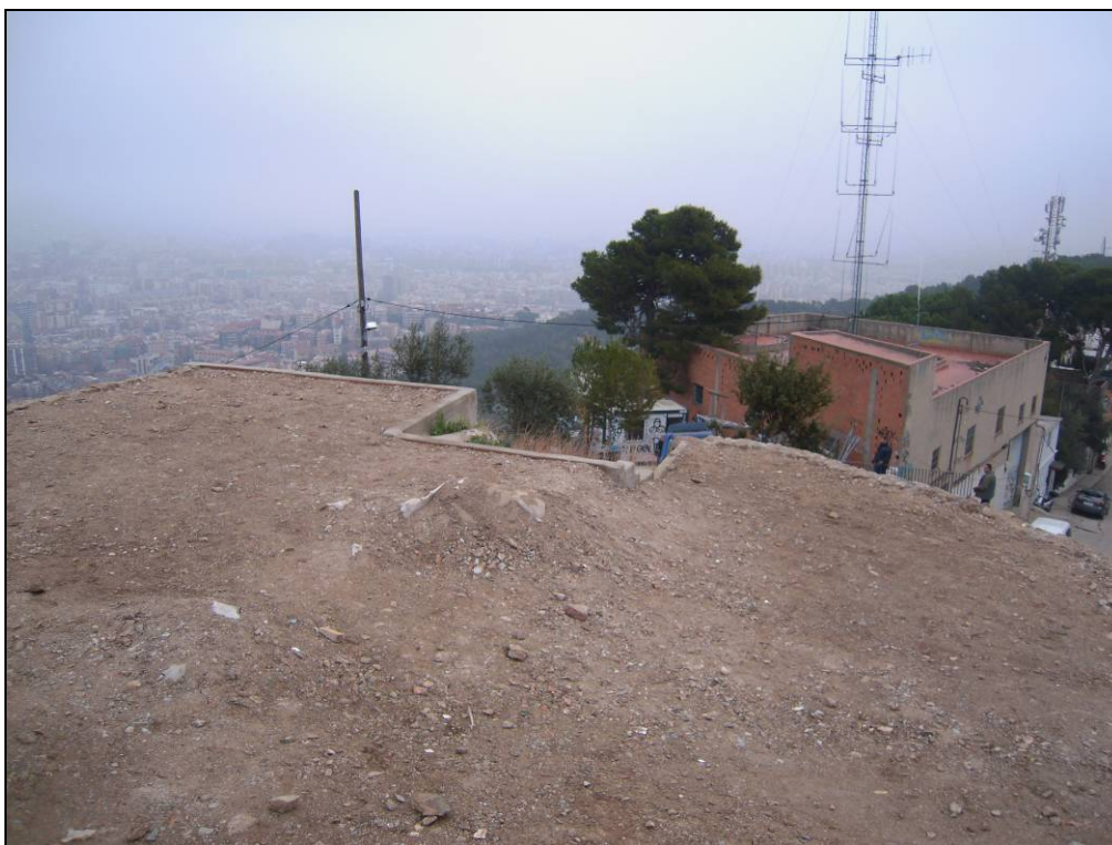
Foto 25: Cobriment del sector est de les barraques aparegudes, pel seu manteniment, davant la impossibilitat de la seva consolidació.
