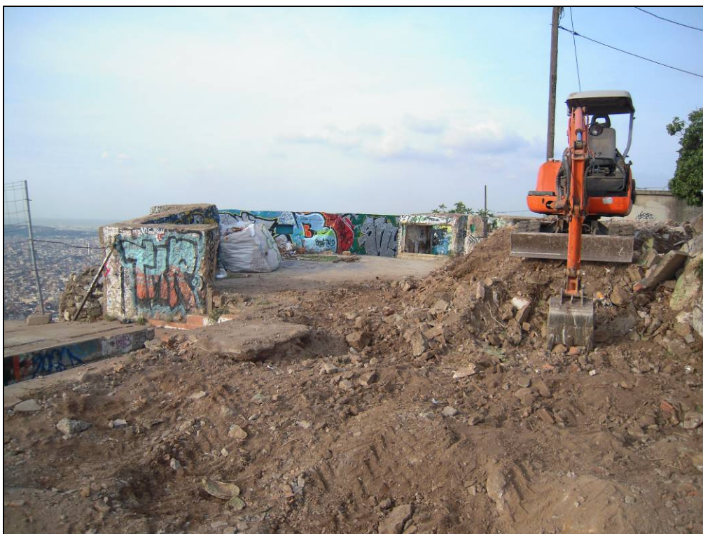
Foto 15: Treballs mecànics de retirada de la runa al punt central de la bateria antiaèria.
