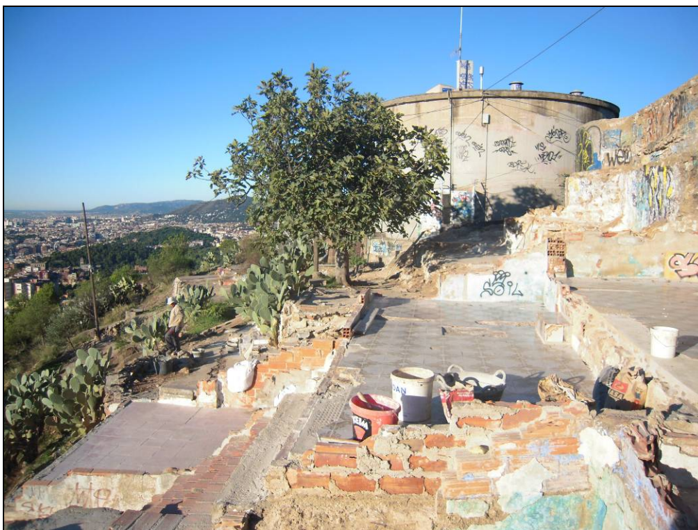
Foto 21: Imatge durant els treballs de consolidació de les estructures del barraqisme.
