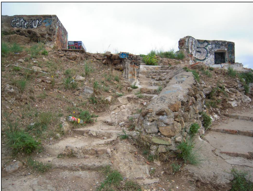
Foto 2: Estat d'un dels accessos a la plataforma superior abans de la neteja superficial.
