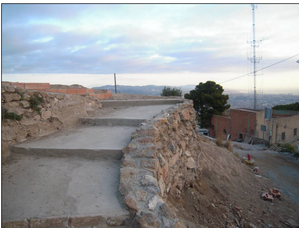
Foto 26: Imatge de detall dels treballs de consolidació d'un accés creat pels barraquistes.
