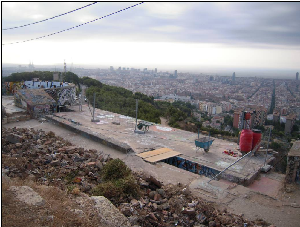
Foto 3: Imatge des del lloc de comandament durant els treballs de condicionament.
