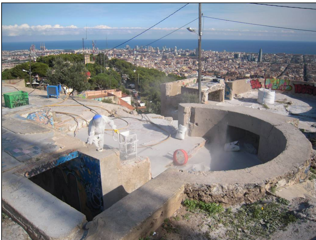
Foto 29: Imatge dels treballs de restauració en l'eliminació dels grafitis de les estructures militars de la bateria antiaèria.
