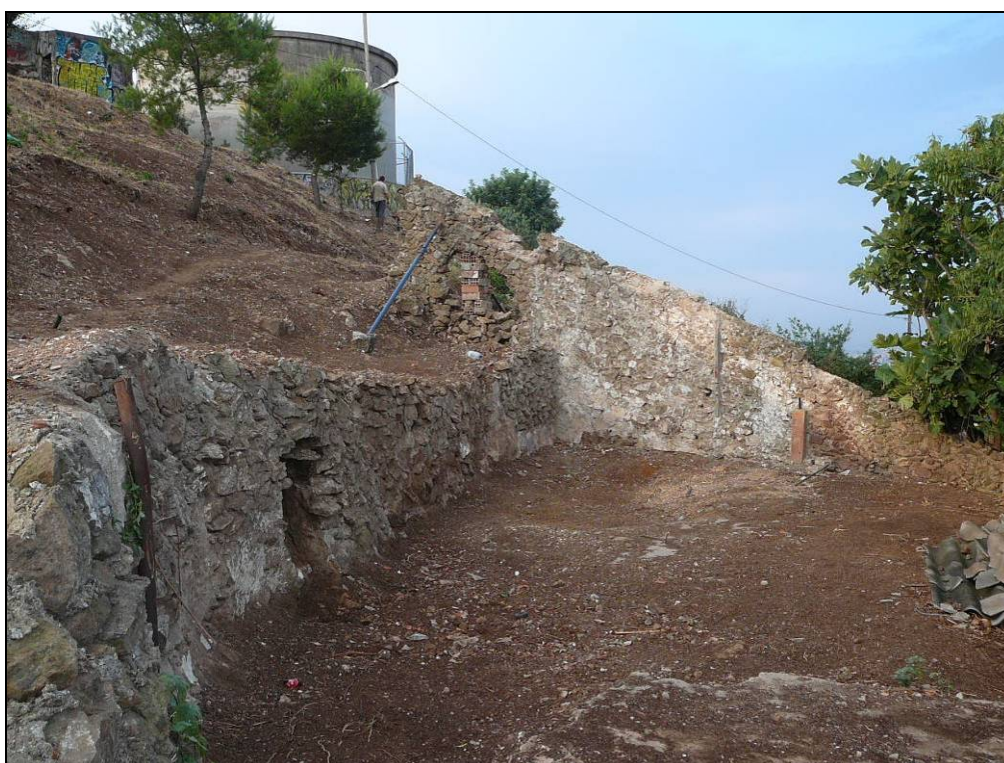
Foto 6: Neteja del sector septentrional per a la recuperació de les terrasses. Al fons, el mur de tanca de la residència de Casa Penyasco o el Castell.
