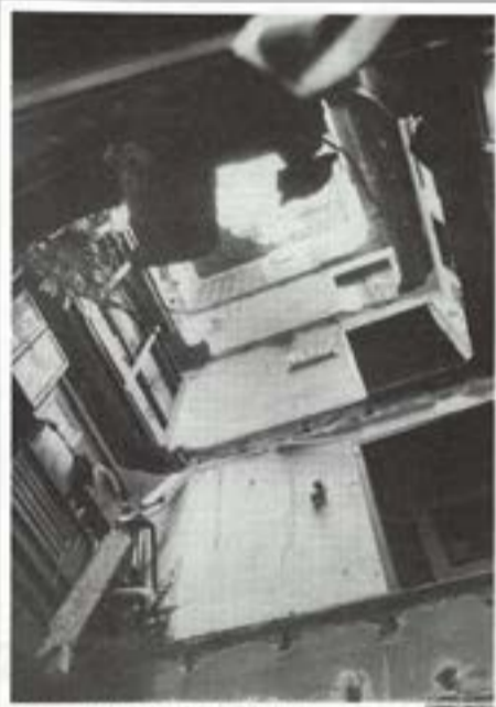
El desplome de un bloque del Turó provocó la alarma
