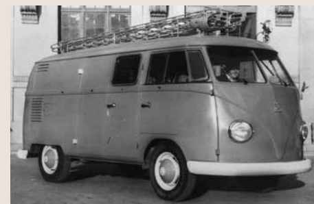
W BT 19 1955. Adquisició de 1955. Furgoneta Volkswagen T1 equipada per l'empresa Kronenburg amb una bomba d'alta pressió per apagar petits incendis. Es va fer servir a la caserna interior de la Fira de Mostres de Barcelona. ABB. El vehicle a l'exposició pertany a la col·lecció privada Marcos Navarro.
