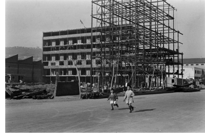
↗ Casa Bloc under construction. 1934. Josep Torres Clavé. AFB
