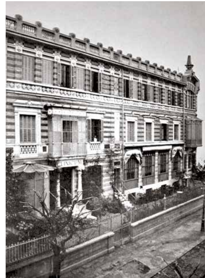
Façana de la clínica quirúrgica del Dr. Cardenal, coneguda com a «Clínicum», reformada per l'arquitecte Bonaventura Pollés Vivó als anys noranta del segle XIX. Font: Clínicum: Casa de curación quirúrgica del Dr. Cardenal. Noticia descriptiva y extracto del reglamento , Barcelona, Salvat, 1899.
