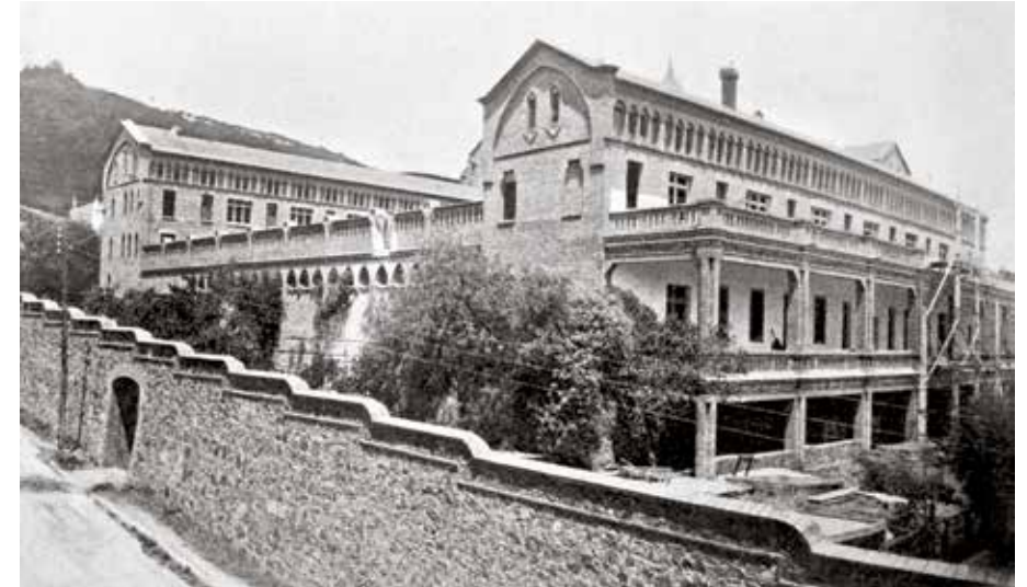
Valldonzella en procés de transformació. Vista de la nau orientada al sud-est, amb l'afegit de la galeria coberta a la planta baixa i una terrassa adicional al primer pis. Les finestres han estat engrandides o transformades en portes. Font: imatge reproduïda dins de l'obra Ajuntament de Barcelona. Conselleria d'Higiene i Sanitat, 1937 , sense paginació.
