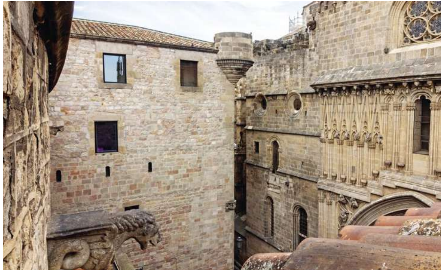
FIGURA 8.6 Exterior del passatge del rei Martí i porta de la tribuna catedralícia, amb la marca de recepció de l'antic pont sobre el carrer, enderrocada l'any 1823. FOTOGRAFIA: Daniel Alcubierre
