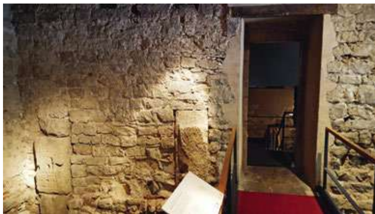
FIGURA 1.27 Tancament meridional del Palau Major amb les espitlleres vers l'androna des de l'interior i l'exterior, i nou tancament de la meitat occidental del Palau del Bisbe, amb els arrencaments dels arcs originals integrats. MUHBA. FOTOGRAFIES: Daniel Alcubierre
