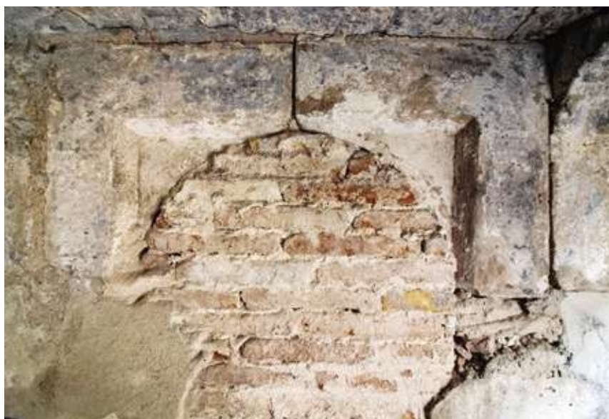
FIGURA 8.4 Tram del passatge del rei Martí que va restar integrat posteriorment al Palau del Lloctinent (Arxiu de la Corona d'Aragó), i detall del portal aparellat que donava accés al nou apartament reial , ubicat a la tercera planta de la Casa de les Escrivanies. MCD-ACA. FOTOGRAFIES: Daniel Alcubierre
