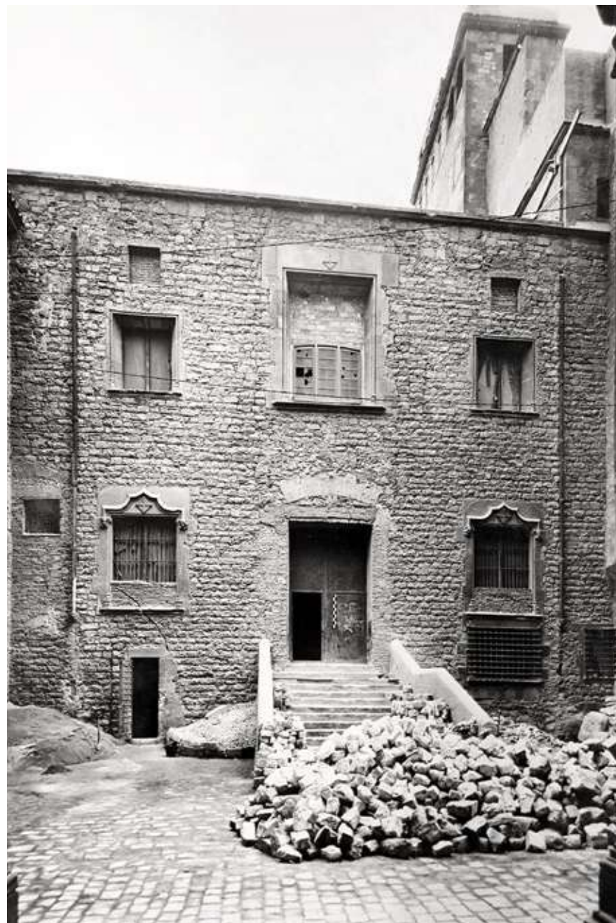
FIGURA 9.7 La façana renaixentista del Tinell vers la Plaça de Sant Iu abans i durant la restauració dels anys quaranta del segle xx. Tot i el trasllat del portal i la transformació de la grada que ja havien dut a terme les monges, encara s'hi aprecien els finestrals i l'acabat amb morter fingint carreu que descriuen les fonts. SPAL-DIBA, AFB i MUHBA
