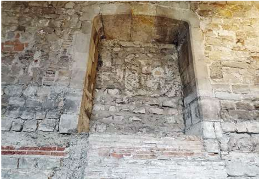
FIGURA 4.13 L'antiga finestra de la recambra del tribunal major vers la sala del negoci o dels escrivans , reconvertida posteriorment en porta arran dels acords amb les monges i finalment aparedada. MUHBA. FOTOGRAFIA: Ramon Pujades
