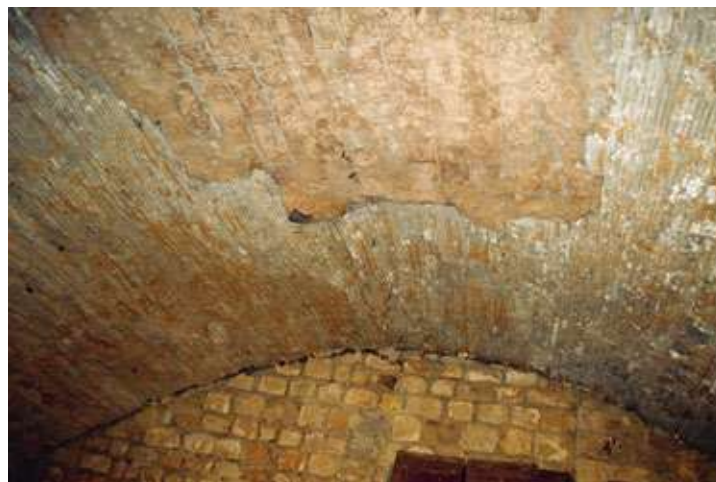
▷ FIGURA 2.31 Detalls de l'extrem occidental de les voltes anterior (sector segregat al segle XVI per incorporar-lo al Palau del Lloctinent) i posterior (tancament original romànic amb espilleres vers l'antiga androna). MUHBA. FOTOGRAFIES: Reinald González
