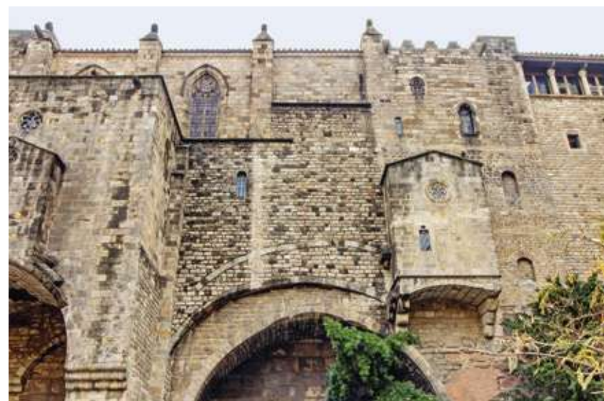
FIGURA 3.1 Detalls de la façana oriental de la Capella Reial. S'hi aprecia com el tancament gòtic va integrar a la part baixa el parament romànic de l'antiga cuina comtal. MUHBA
