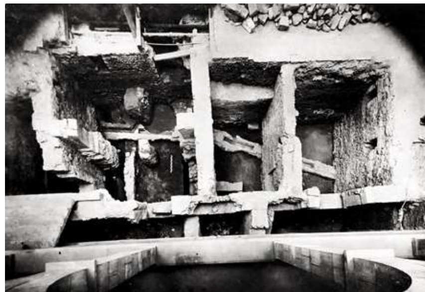
FIGURA 1.3 Excavació de les estructures del sector occidental del primitiu Palau del Bisbe el 1950. S'hi aprecien la gran torre central, els dos petits cossos intermedis i una de les torres laterals. AFB. FOTOGRAFIA: Joan Estorch
