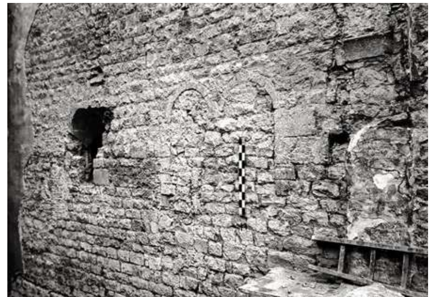
FIGURA 2.18 Descobriments del cos aparellat de finestres romàniques de la façana posterior l'any 1945. AFB. FOTOGRAFIA: Francesc Ribera
