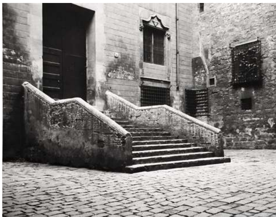
FIGURA 9.7 La façana renaixentista del Tinell vers la Plaça de Sant Iu abans i durant la restauració dels anys quaranta del segle xx. Tot i el trasllat del portal i la transformació de la grada que ja havien dut a terme les monges, encara s'hi aprecien els finestrals i l'acabat amb morter fingint carreu que descriuen les fonts. SPAL-DIBA, AFB i MUHBA
