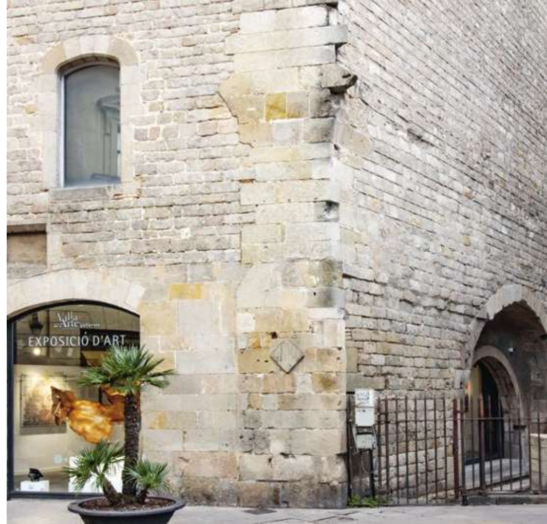
FIGURA 8.11 Restes estructurals del monestir celestí integrades a les bases del posterior edifici de la Pia Almoina. MUHBA. FOTOGRAFIA: Daniel Alcubierre
