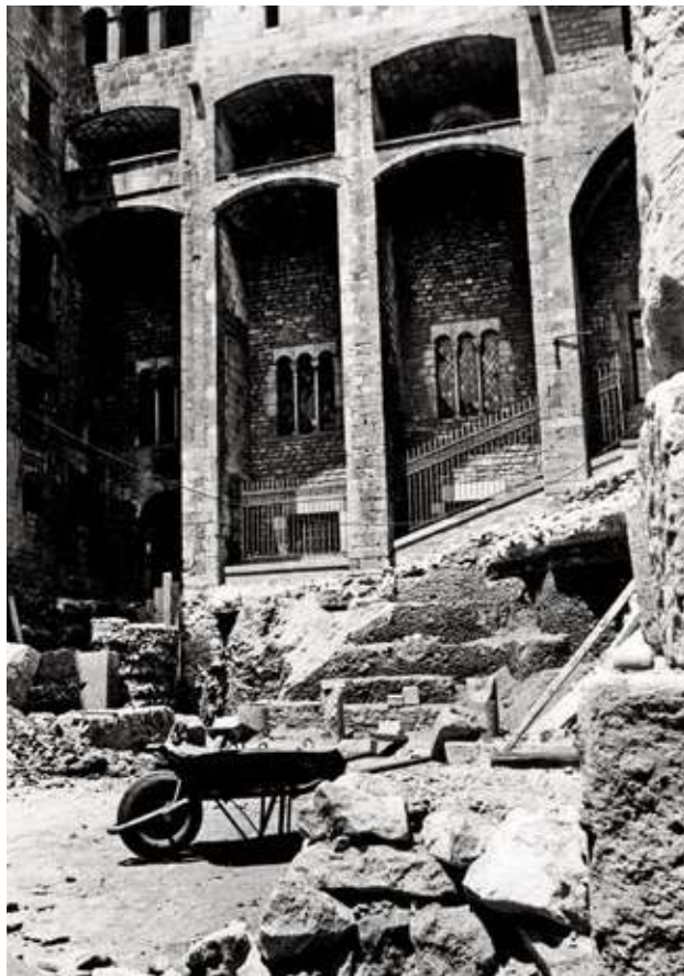
FIGURA 6.2 Fonamentació dels contraforts del Tinell, deixada a la vista l'any 1961 per les obres de cobertura de la Plaça del Rei. MUHBA
