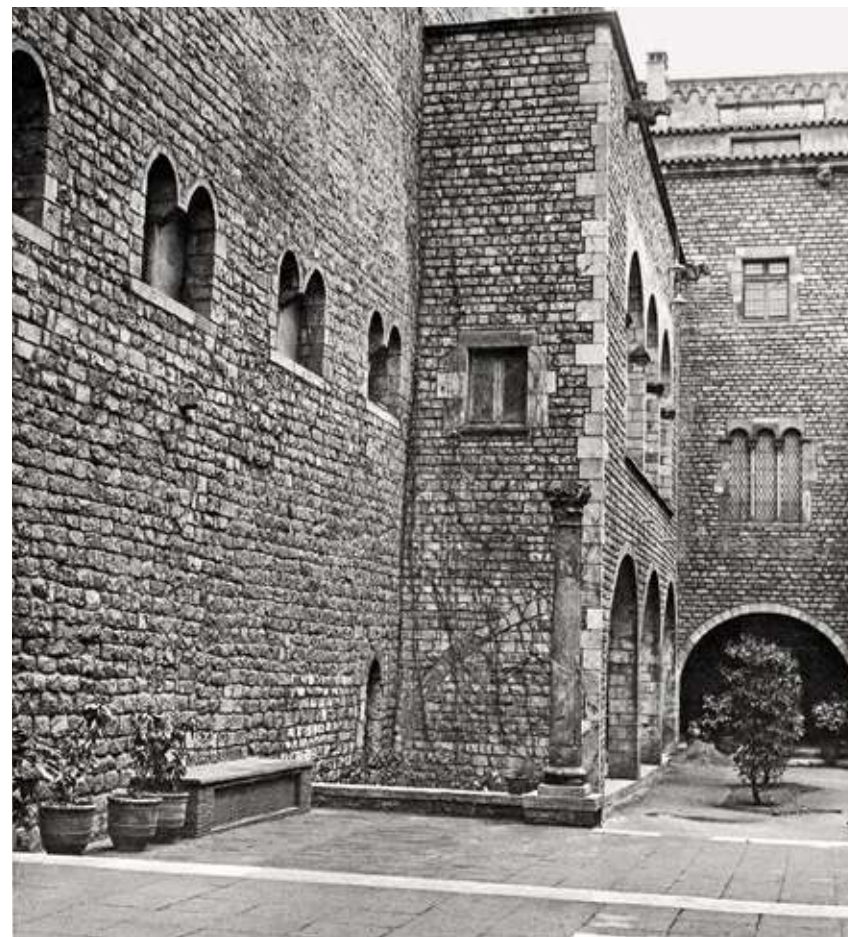
FIGURA 2.20 La façana posterior als anys seixanta del segle xx, amb la porta i els finestrals romànics ja reconstruïts pels restauradors. MUHBA
