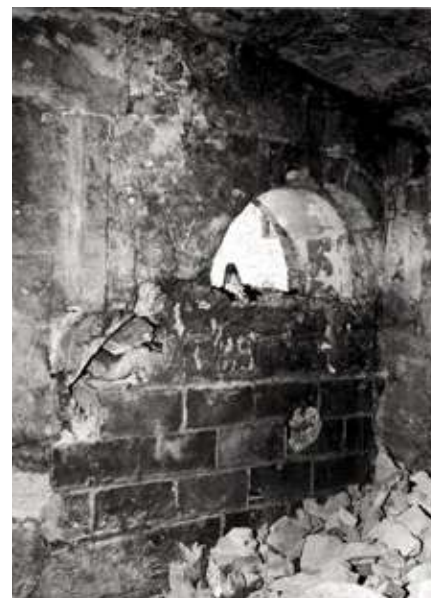
FIGURA 2.11 Descoberta del finestral romànic bifor sobre la porta principal, que havia estat ocultat per la barbacana-mirador gòtica. MUHBA
