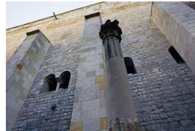
FIGURA 2.23 La façana posterior en l'actualitat, amb els finestrals i la porta romànics parcialment ocultats pels contraforts contemporanis. MUHBA
