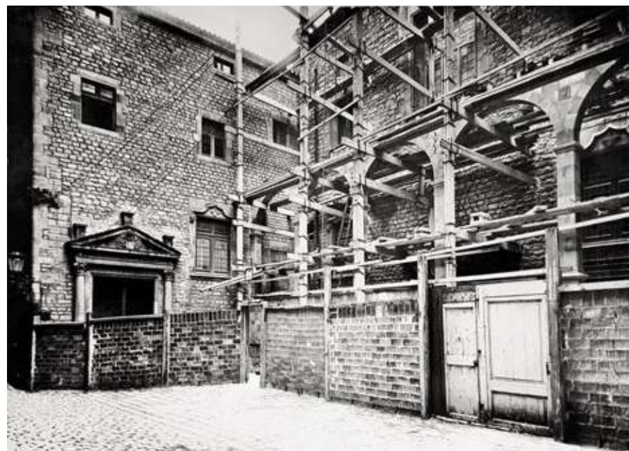
FIGURA 9.8 Localització de la base de la grada semicircular d'Antoni Carbonell per les excavacions de 1946 i inici de la construcció de la desafortunada llotja historicista de Joaquim de Ros i de Ramis, que va acabar d'anul·lar la percepció de la façana projectada per Carbonell. AFB. FOTOGRAFIES: Francesc Ribera
