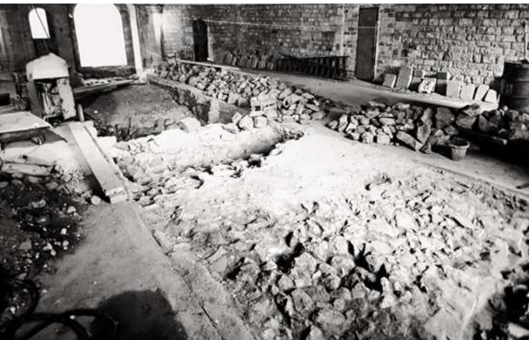
FIGURA 2.36 Vista del parament que recobreix les voltes romàniques, en retirar-se el paviment del Tinell l'any 1971 per instal·lar l'atirantat d'estabilització contemporani. AFB i MUHBA
