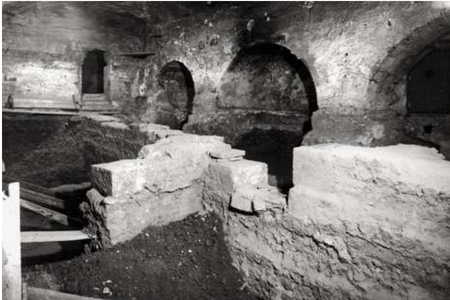
FIGURES 5.11 i 5.12 Sector oriental i sector occidental de la volta romànica posterior a l'inici de la intervenció arqueològica del 1952. Al sector oriental, l'excavació deixa a la vista la banqueta de fonamentació de la volta; a l'occidental, encara s'hi veu el mur medieval que separava l'àrea de cavallerisses de la resta de la volta, posteriorment destruït. MUHBA
