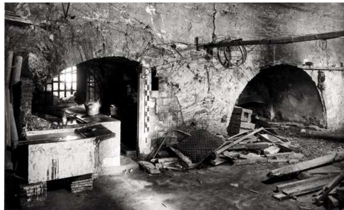
FIGURES 5.9 i 5.10 Extrem oriental de la volta romànica posterior a l'any 1945. S'hi aprecien les restes de l'encanyissat original i la factura dels arcs de reforç bastits al segle XIX per estabilitzar la façana septentrional del palau, a més de la finestra enreixada vers el verger que havia obert la Inquisició en usar aquest sector com a presó pública. MUHBA
