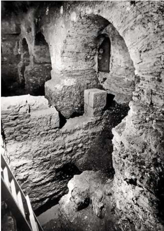
FIGURA 2.21 La cara interna de la porta romànica del verger durant les excavacions de l'any 1952, coberta per un dels arcs de consolidació bastits al primer terç del segle XIX. AFB
