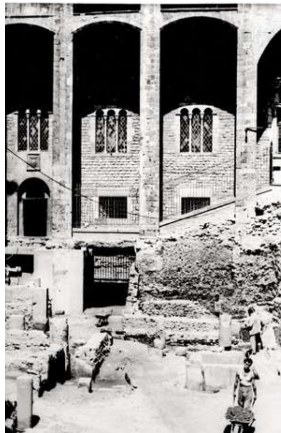
FIGURA 6.2 Fonamentació dels contraforts del Tinell, deixada a la vista l'any 1961 per les obres de cobertura de la Plaça del Rei. MUHBA
