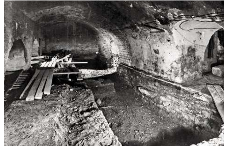
FIGURES 5.11 i 5.12 Sector oriental i sector occidental de la volta romànica posterior a l'inici de la intervenció arqueològica del 1952. Al sector oriental, l'excavació deixa a la vista la banqueta de fonamentació de la volta; a l'occidental, encara s'hi veu el mur medieval que separava l'àrea de cavallerisses de la resta de la volta, posteriorment destruït. MUHBA
