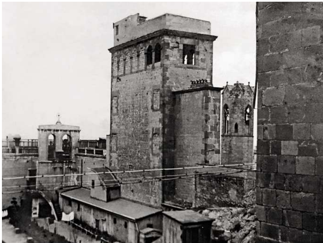
FIGURA 4.14 Vista del terrat major del palau l'any 1914, amb les estructures construïdes per les monges al lloc on hi havia hagut les internacions del Sant Ofici sobre el terrat. SPAL-DIBA
