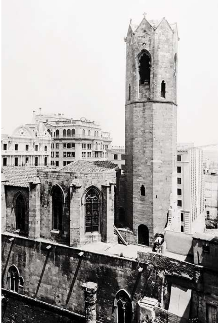
FIGURA 3.6 La cara exterior de l'absis de la Capella Reial vers l'any 1930. S'hi aprecia que el contrafort exempt més proper al campanar va ser afegit improvisadament quan ja havia estat acabada la motllura del finestral. SPAL-DIBA. FOTOGRAFIA: N. Ricart
