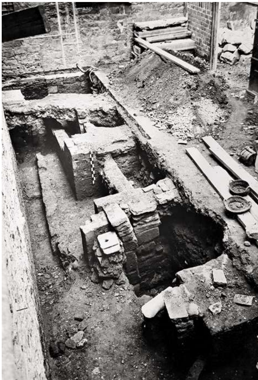
FIGURA 1.2 Localització de les estructures del primitiu Palau del Bisbe en les excavacions a la Plaça de Sant Iu del 1946. En primer pla, els arrencaments dels arcs que en defineixen el cos central. AFB. FOTOGRAFIA: Francesc Ribera
