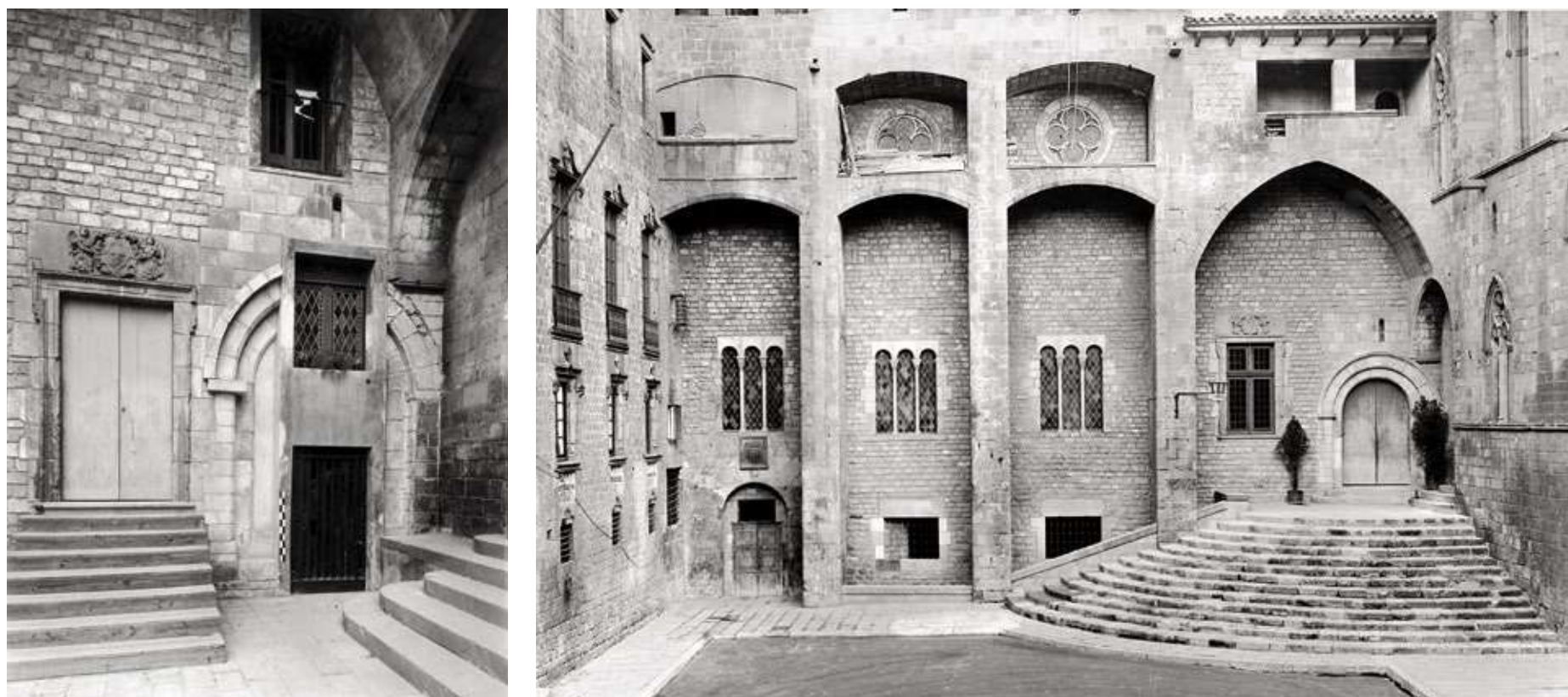
FIGURA 4.10 Portal barroc obert per la Diputació del General a la façana principal, reconvertit en finestra per la restauració contemporània. MUHBA. FOTOGRAFIA (2): F. Estorch
