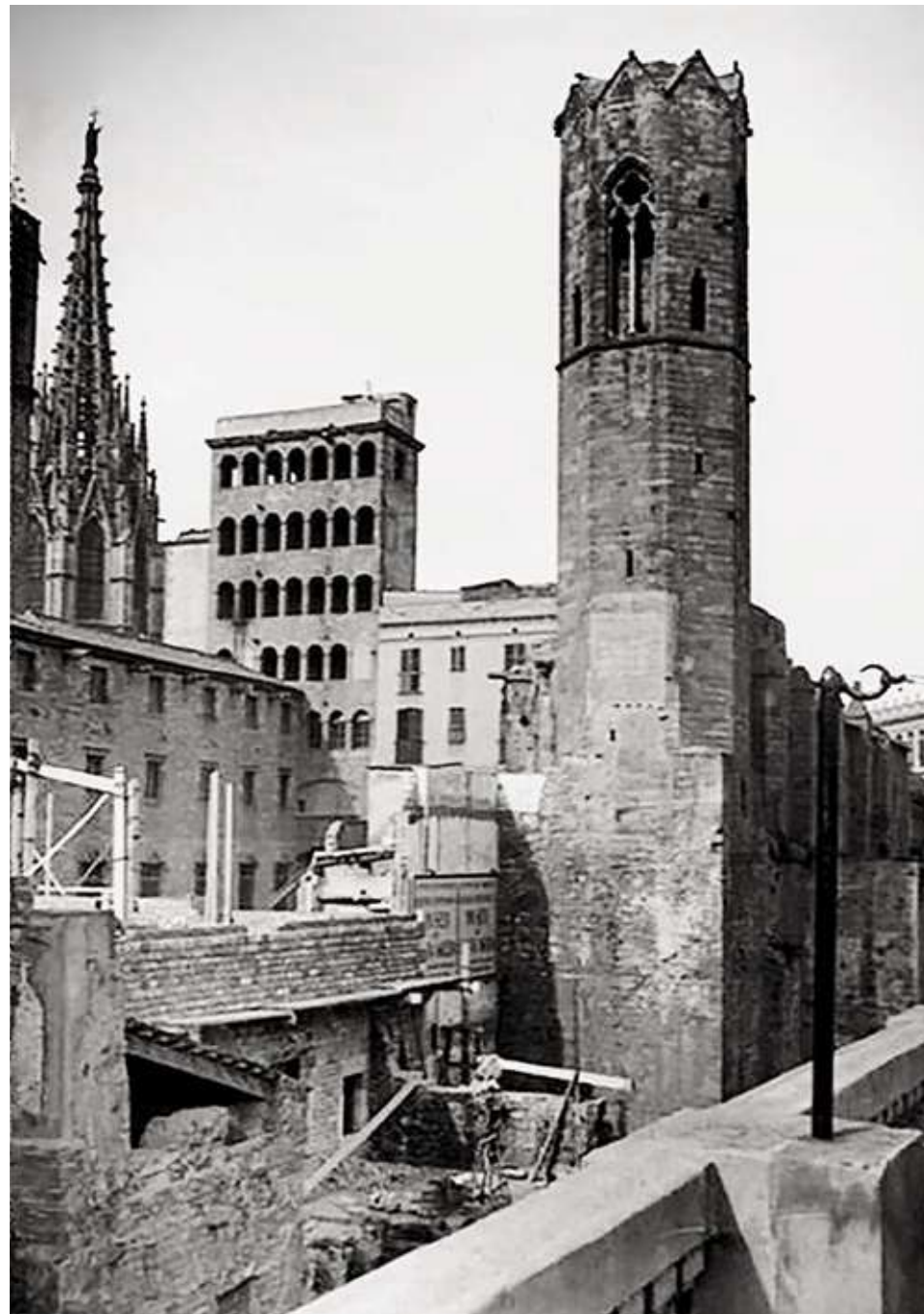
FIGURA 1.23 Les obres de trasllat de la Casa Padellàs a la seva ubicació actual l'any 1935, amb la Capella Reial i la Plaça del Rei al fons. IAAH, Arxiu Mas. FOTOGRAFIA: Adolf Mas
