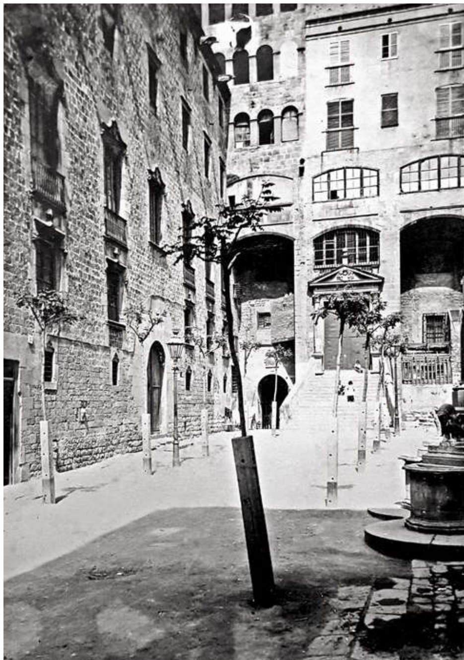
FIGURA 2.6 El sector occidental de la façana principal del palau vers l'any 1888, amb el nou edifici contemporani aixecat per les monges sobre una part del Tinell. AFB
