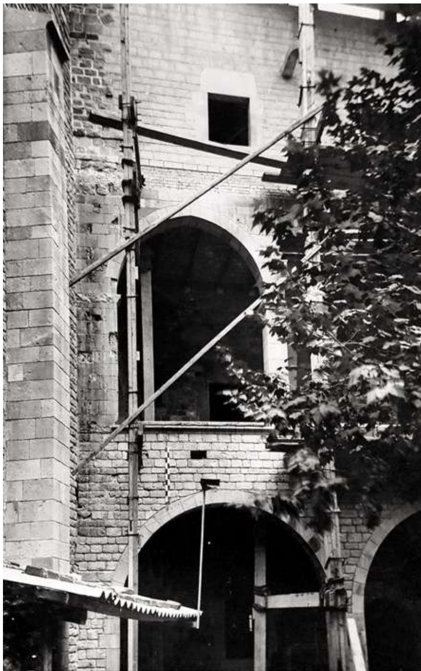
FIGURA 8.9 Obres de recreació de la galeria septentrional del verger a partir de l'única pilastra original preservada, l'any 1950. AFB. FOTOGRAFIA: Francesc Ribera
