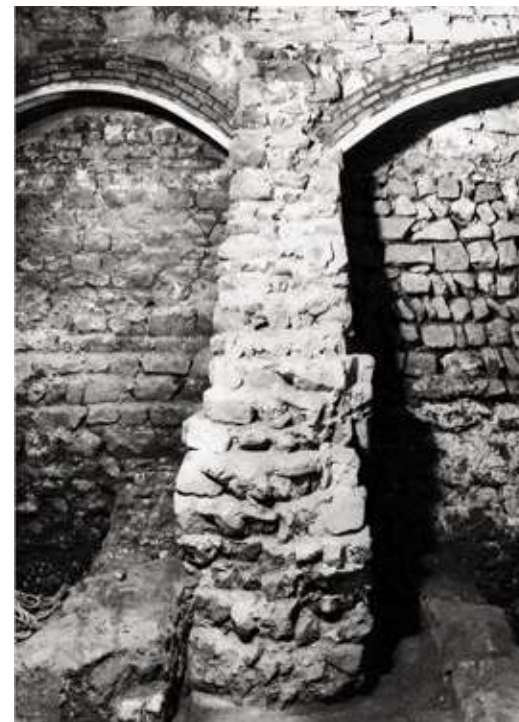
◁ FIGURA 2.27 Cara exterior del tancament de llevant l'any 1952, ja enderrocats els pisos que havien ocupat el solar de l'avantcambra. Sota la porta aparedada del Tinell, s'hi comprova que només la volta anterior havia continuat històricament fins a incorporar la muralla romana. MUHBA
