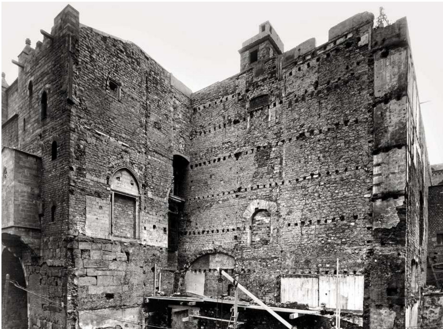
FIGURA 4.4 Tancaments meridional (Capella Reial) i occidental (Tinell) del palau petit l'any 1952, abans de l'actuació dels restauradors. S'hi aprecien els canvis en el parament i les marques de recepció de les voltes. MUHBA
