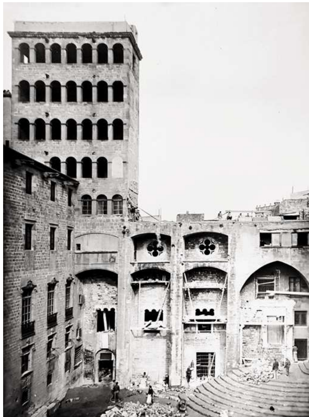
FIGURA 2.9 La façana principal l'any 1943, en plena campanya de restauració. S'hi aprecia la vacil·lació pel que fa a l'obertura a l'exterior del segon cos de finestrals romànics. AFB
