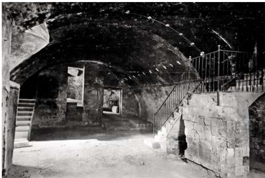
FIGURA 2.32 El sector occidental de la volta romànica anterior l'any 1945, abans de la restauració, quan encara es mantenien obertes les comunicacions amb el sector annexat al Palau del Lloctinent, que havia servit com a cripta conventual. AFB i MUHBA
