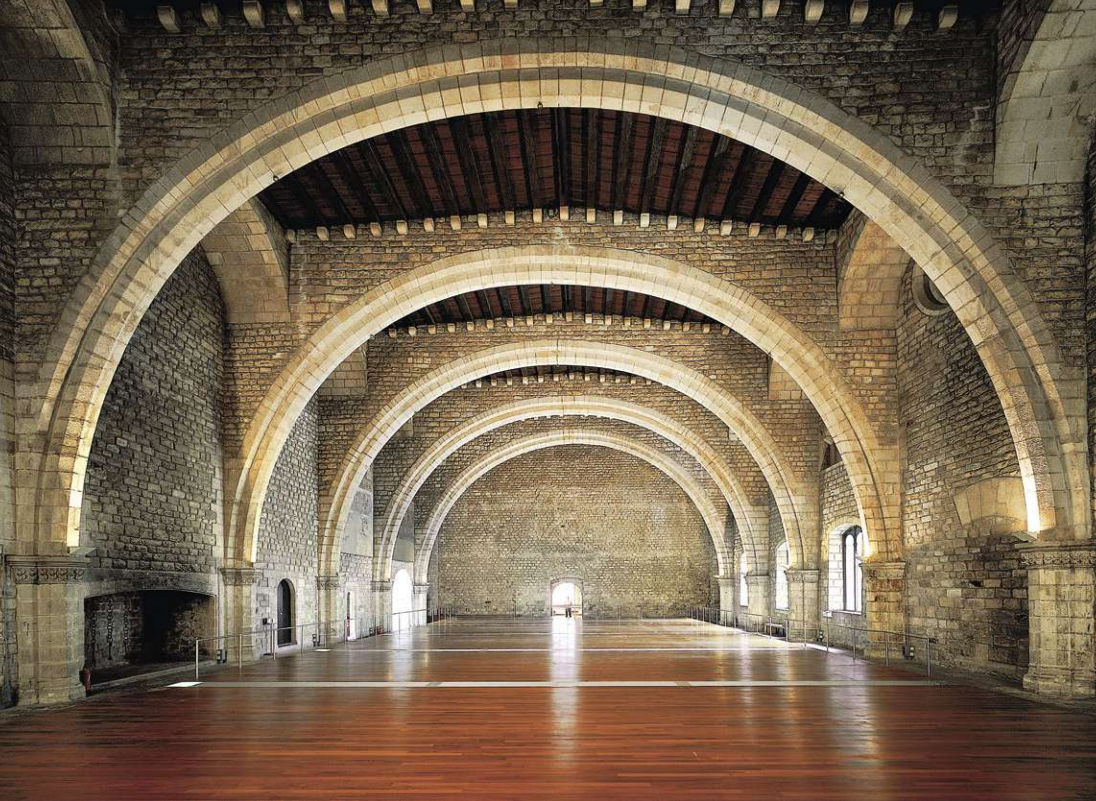
FIGURA 6.4 El Tinell vist des de la capçalera, amb els grans arcs diafragmàtics que sostenen la coberta. MUHBA. FOTOGRAFIA: Pere Vivas
