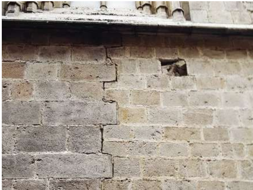
FIGURA 1.29 Línia de contacte entre el parament del segle xiv (al costat esquerre, de carreus més grossos) i l'obra del segle xv al lateral oriental de la catedral. FOTOGRAFIA: Ramon Pujades
