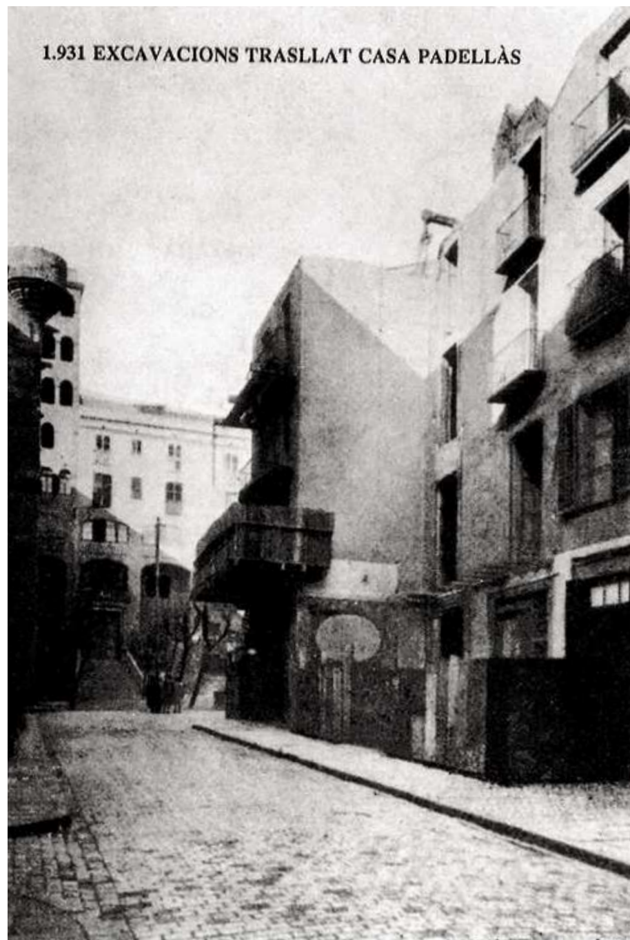
FIGURA 1.19 El carrer del Veguer i la Plaça del Rei l'any 1931, en iniciar-se les demolicions per al trasllat de la Casa Padellàs. MUHBA
