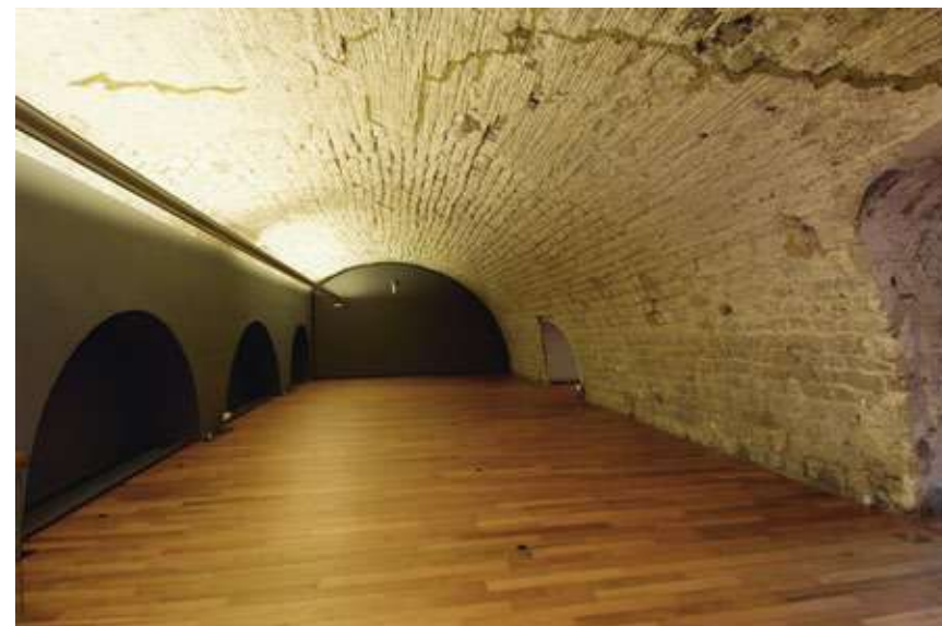
FIGURA 2.35 La volta posterior, amb el tancament de llevat al fons. A l'extrem, s'hi aprecia la forma i disposició de les pedres que la conformen, en haver optat els restauradors contemporanis per eliminar-ne el morter original amb marca de l'encanyissat. MUHBA
