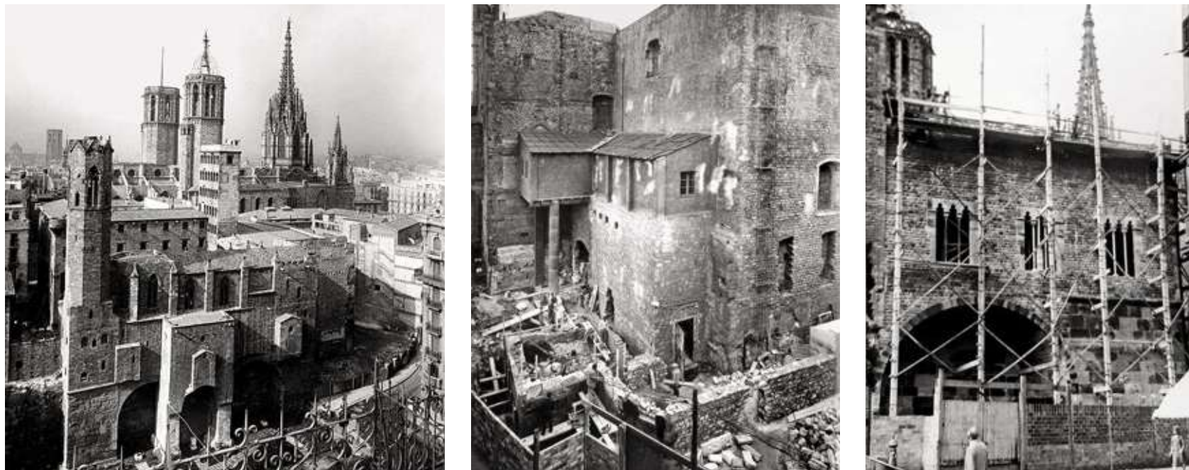
FIGURA 4.5 El solar del palau petit entre el 1951 i el 1959. S'hi veu la comunicació provisional prèvia i la construcció de l'actual avantcambra historicista. AFB i MUHBA
