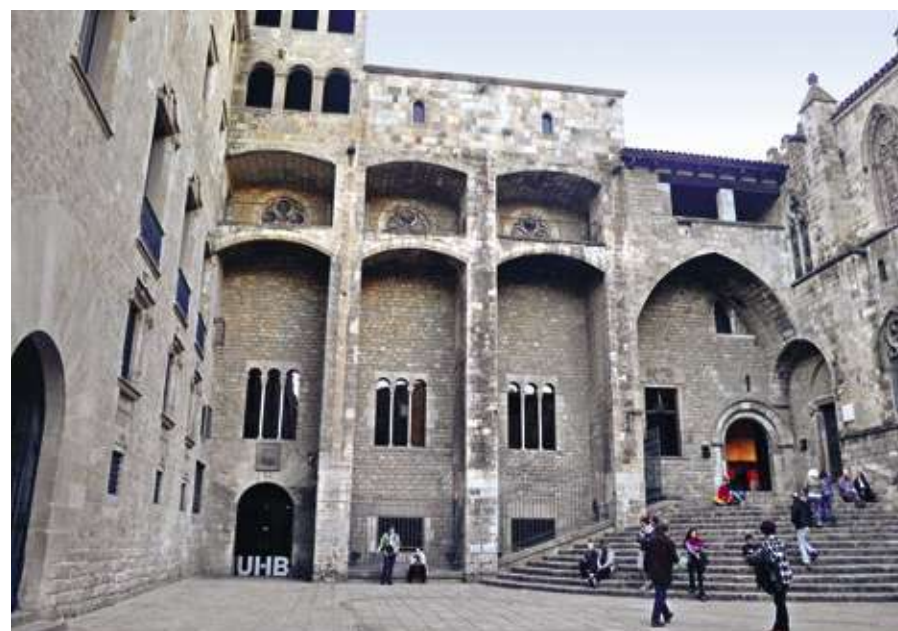
FIGURA 8.7 Prolongació del passatge del rei Martí com a corredor obert per la façana principal, amb mutilació de la motllura de la rosassa major (ara dins del Palau del Lloctinent) i perforació dels contraforts del Tinell. Hi destaca la diferència de factura entre les voltes inferiors (de rajola de pla amb restes de l'encintat original) i les superiors (de carreus de pedra). MCD-ACA i MUHBA. FOTOGRAFIES: Daniel Alcubierre i Ramon Pujades
