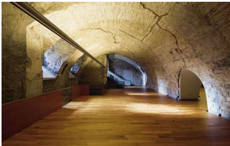
FIGURA 2.34 La volta anterior, amb l'entrada renaixentista del Mestre Racional i el mur de segregació de la cuina del Palau del Lloctinent al fons. Preserva la major part del morter amb marca de l'encanyissat original. MUHBA
