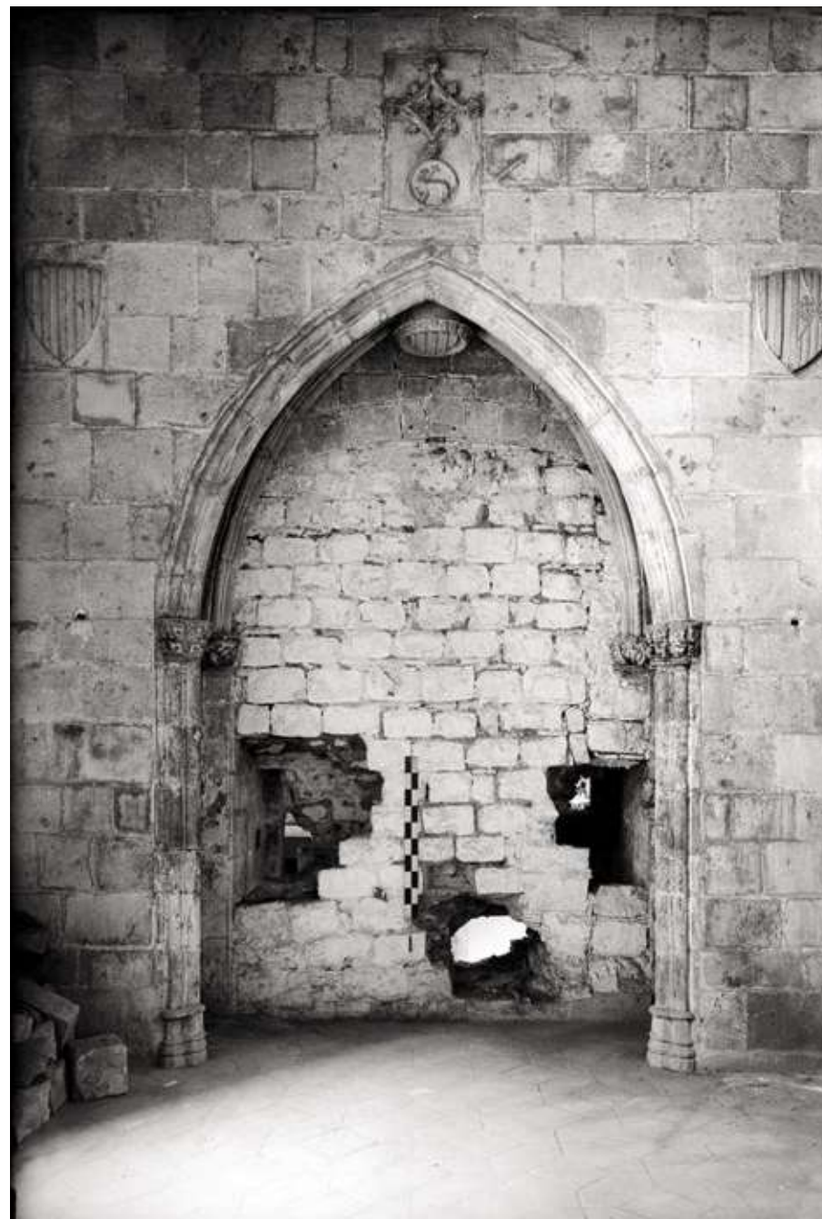
FIGURA 3.14 Nova portada interior creada per Elies Rogent, sobre la porta original aparedada, amb els arcs i elements escultòrics de la galeria bífora desmuntada prèviament. AFB. FOTOGRAFIA: Francesc Ribera
