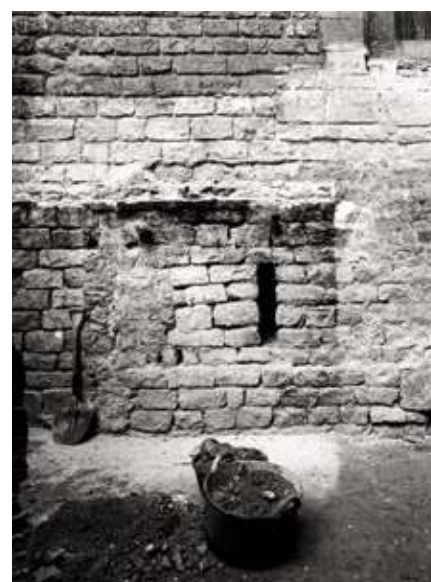
FIGURA 2.13 Cara exterior de l'espitllera romànica oculta per la grada gòtica durant els treballs que van desmuntar la grada l'any 1983 per a la seva posterior consolidació. MUHBA
