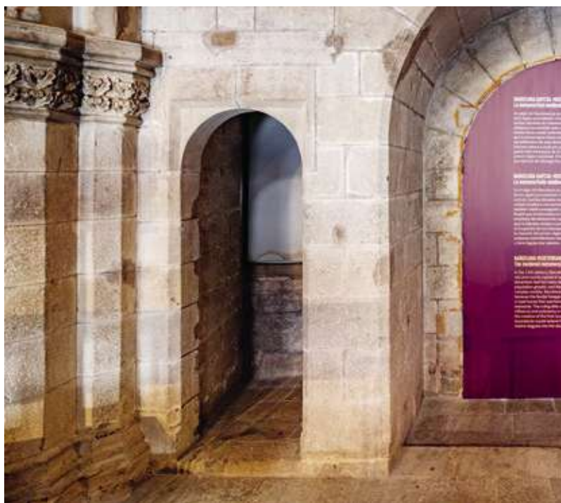
FIGURA 6.6 Vestigis de l'antiga porta del Tinell vers la cuina, on començava l'escala construïda en temps del rei Martí per comunicar les dues sales de parament, i un dels portalets amb llinda partida oberts al mur de regularització del Tinell, característics del seu regnat. MUHBA. FOTOGRAFIES: Neus Castellano i Daniel Alcubierre
