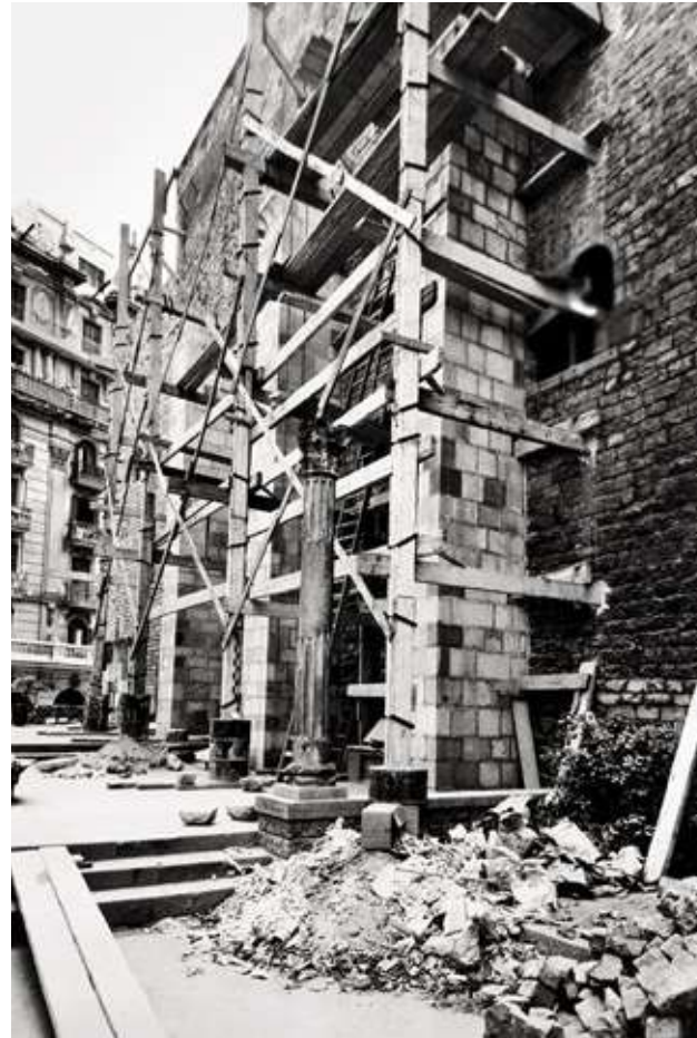
FIGURA 2.22 Construcció dels contraforts contemporanis requerits per a l'atirantat estabilizador del Tinell l'any 1972. AFB. FOTOGRAFIA: Francesc Ribera
