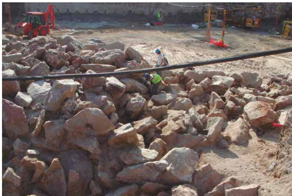
Fig. 1. Excavació de l'escullera medieval. Mikel Soberón.
