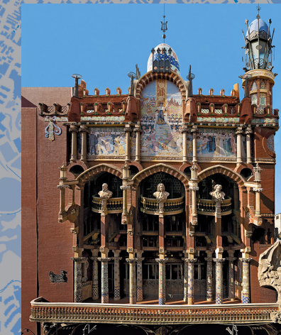
20. Palau de la Música Catalana (1905-1908). Sant Pere Més Alt, 11 / Amadeu Vives, 1. Edificació d'obra nova. Equipament
