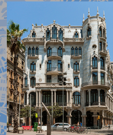
21. Casa Fuster (1908-1910). Passeig de Gràcia, 132. Edificació d'obra nova. Habitatge
