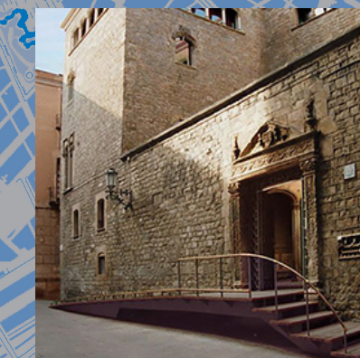
17. Casa de l'Ardiaca (1902). Santa Llúcia, 1. Intervenció en edificació existent. Equipament
