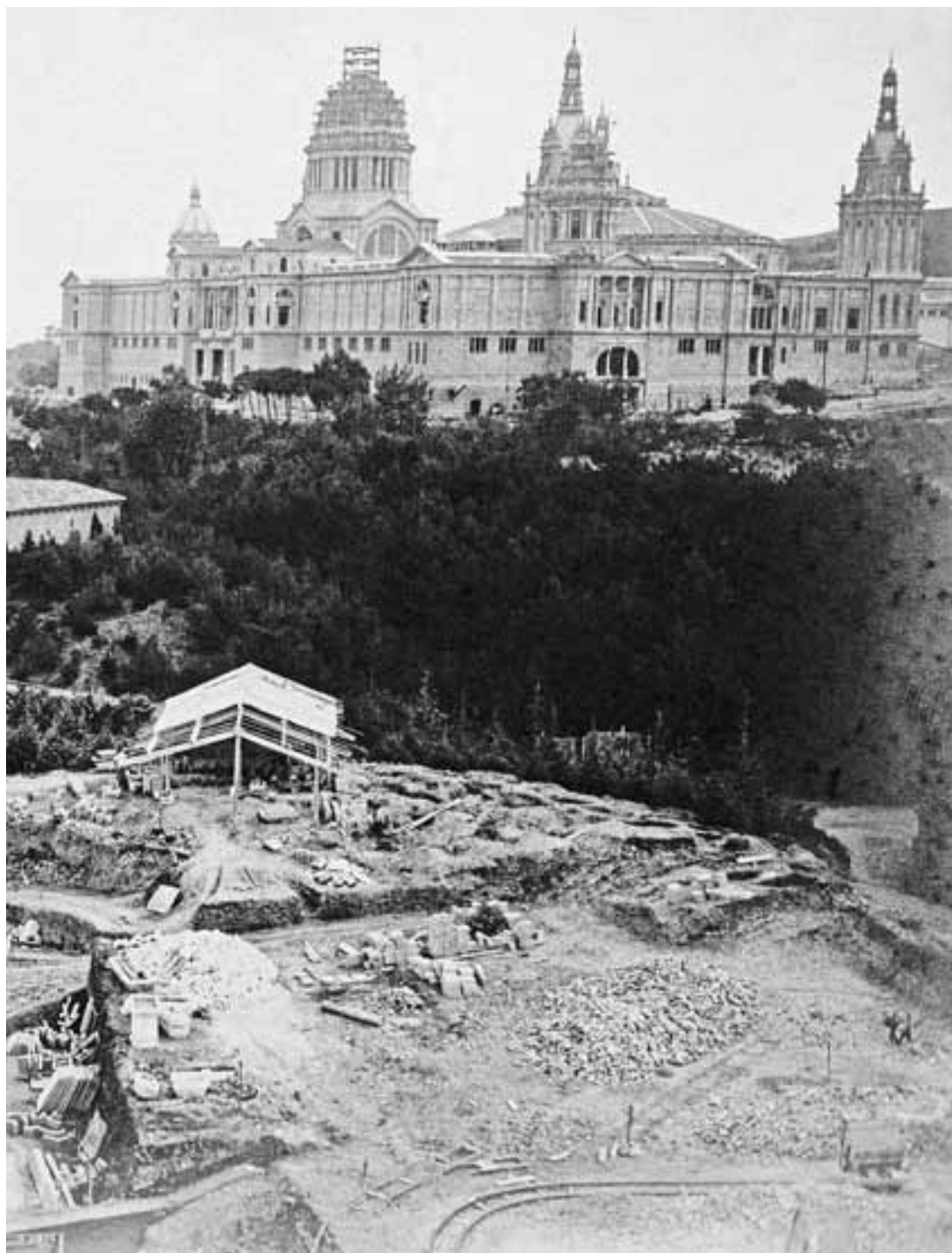
El Pueblo Español en construcción, 1929
