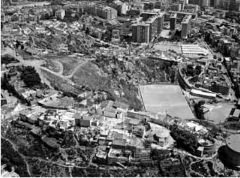
Núcleos barraquistas de El Carmel. En primer plano, el barrio construido sobre la batería antiaérea de la colina de la Rovira
