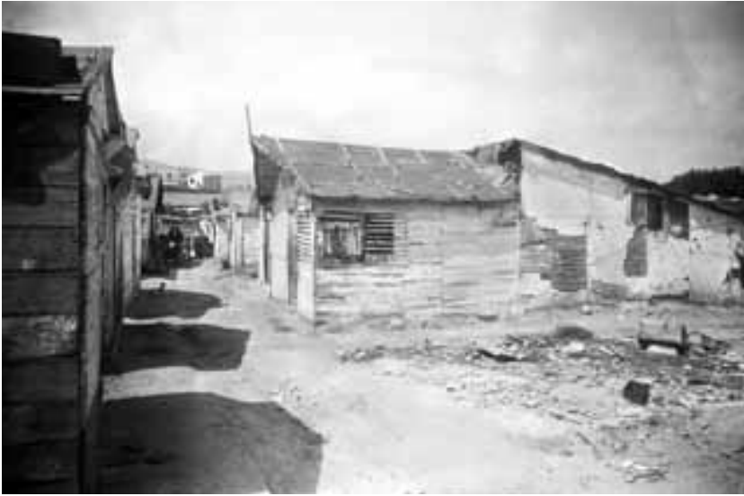
Barraca de madera, cañizo y techo de cartón cuero en La Magòria, años veinte
