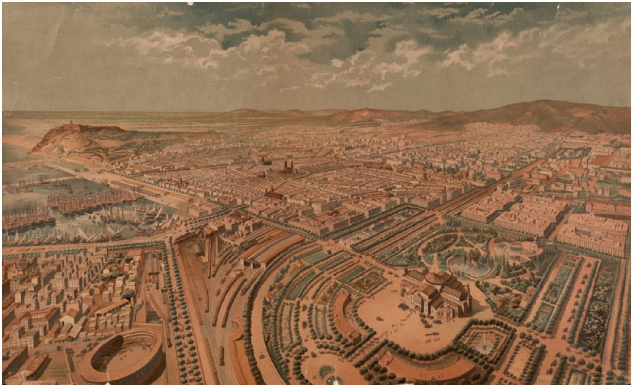
Antonio Casteluch Vendrell. Vista tomada por el lado del fuerte de Don Carlos a 380 metros de distancia y 350 metros de altura sobre el nivel del mar, 1882, AHCB
