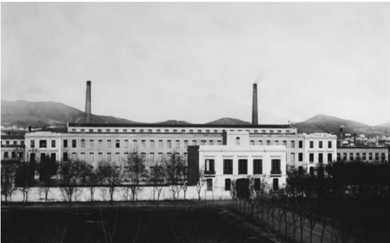
Fachada de La España Industrial, 1860, RB
