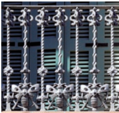
11. Detalle de la barandilla de la fachada de M. Comas i Thos, casa Emili Marfà i Artigas, calle de Ali Bei, 29, 1900
