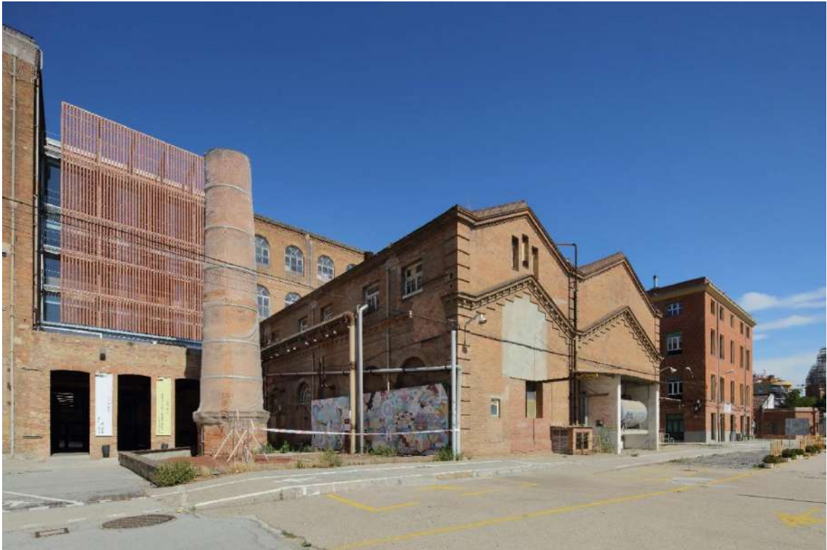
Vista de la Fabra i Coats amb la Sala de Calderes al centre.
