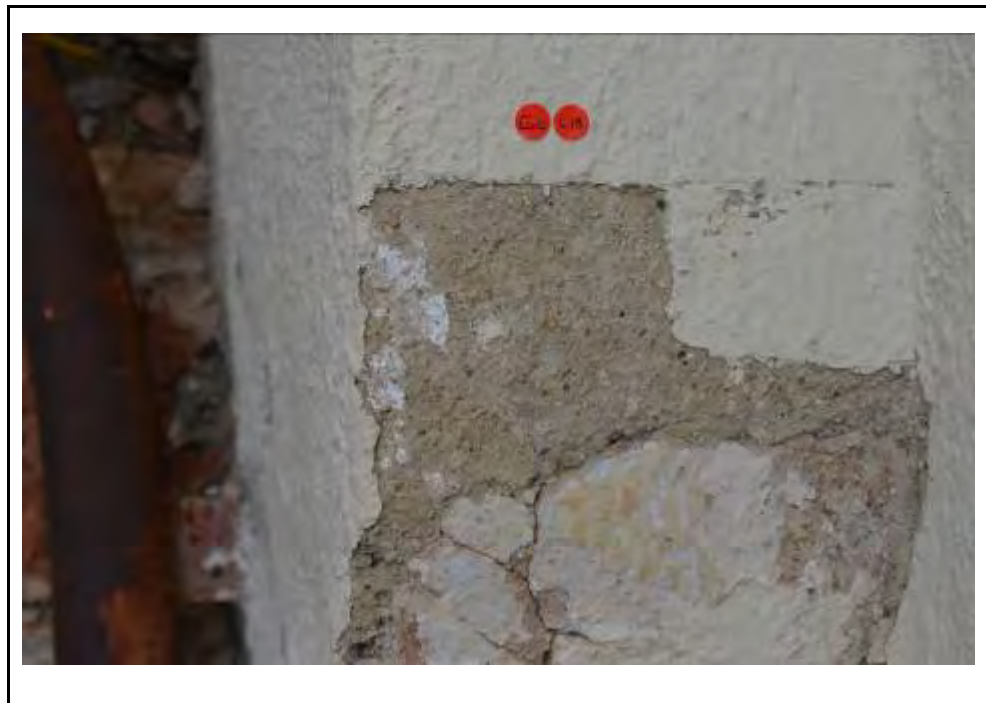
Cala 18 a l'exterior a tocar a la porta actual d'accés. Les parets exteriors estaven arrebossades amb ciment
