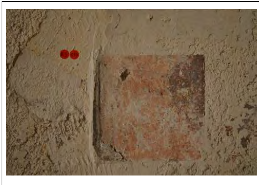
Cala 13 al mur B3. Realitzada per esbrinar les dimensions de la porta original
