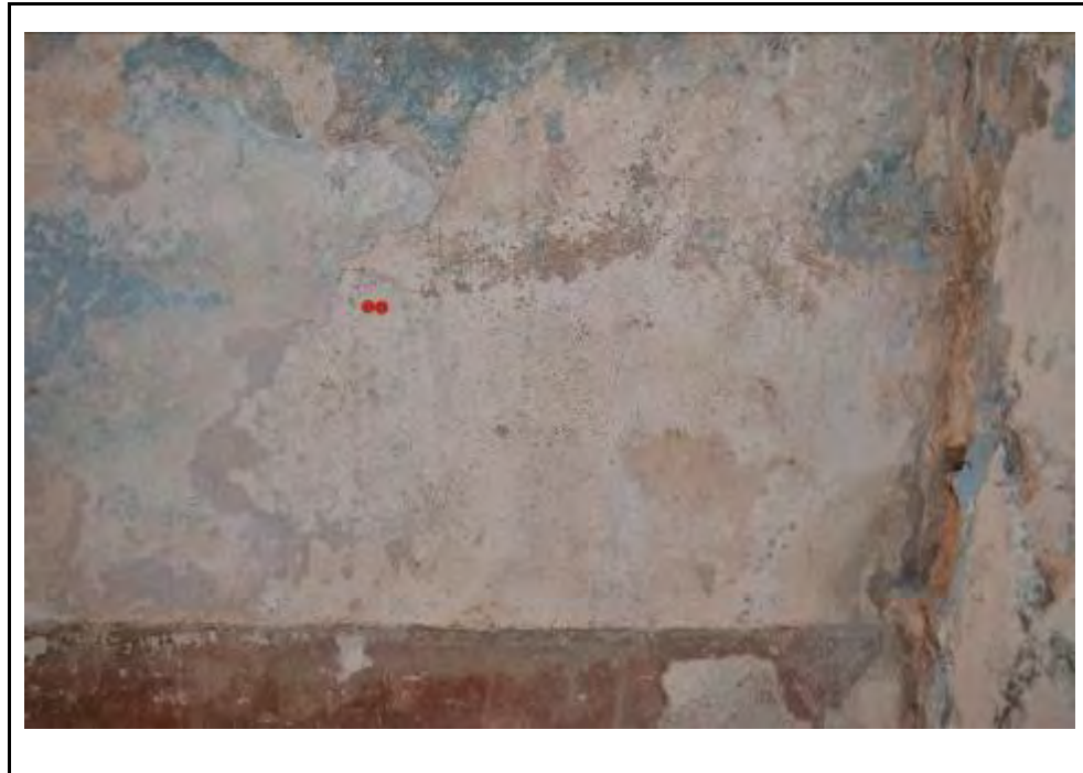
Cala 3 al mur A1
