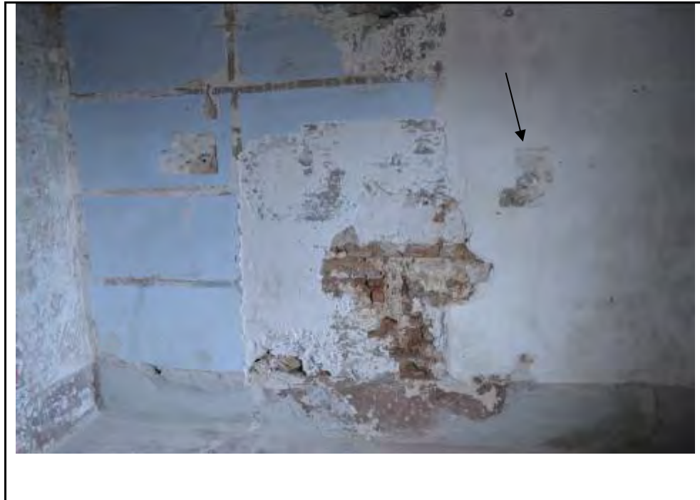
Cala 15 al mur C2
