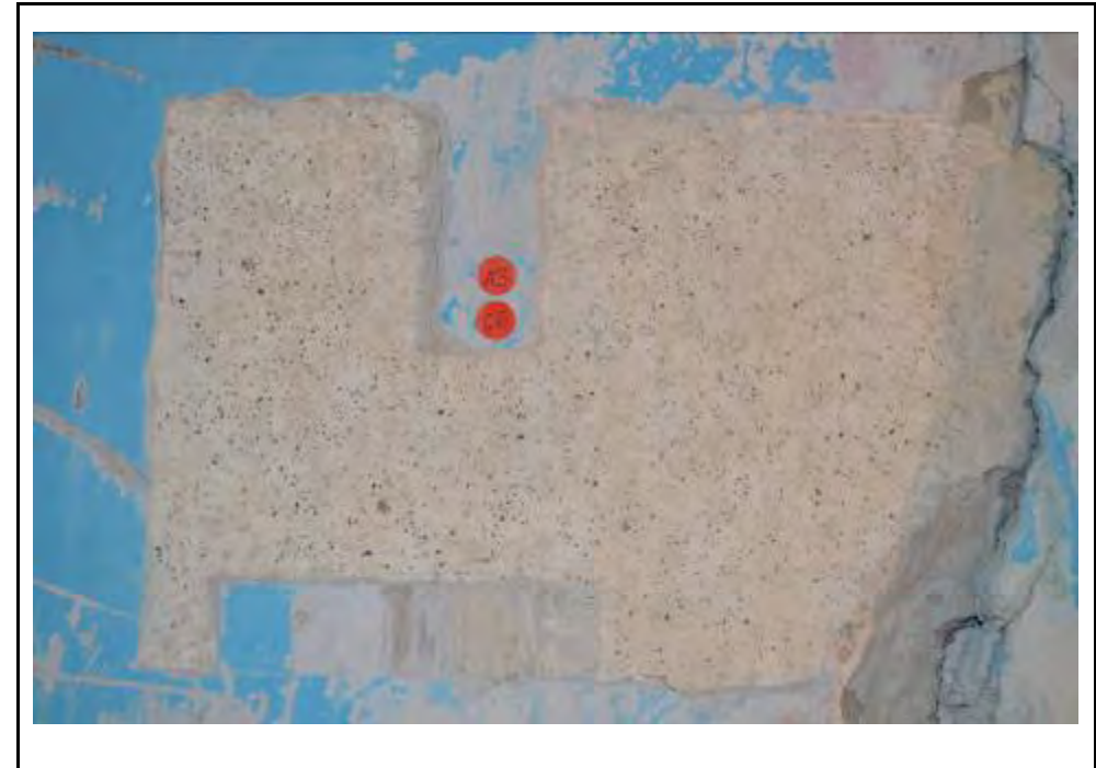
Cala 6 al mur A3
