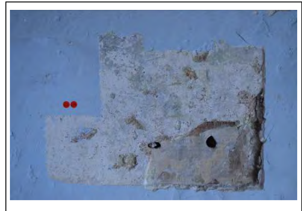
Cala 14 al mur C2. Detall de la capa de morter i pintat en un to blavós durant la guerra
