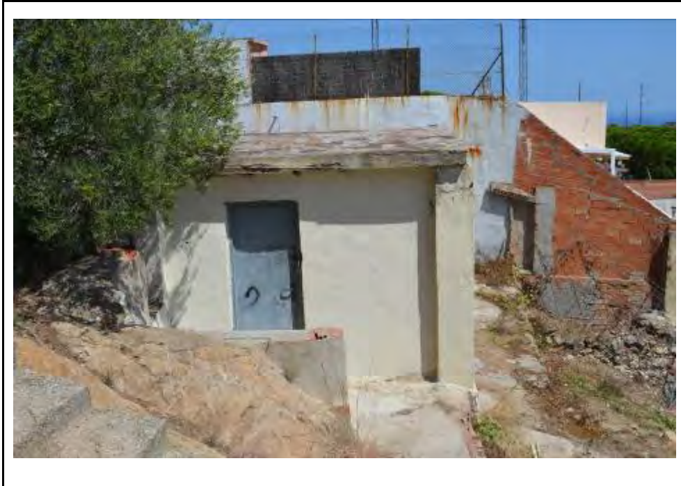
Porta actual d'accés al Pavelló d'Oficials
