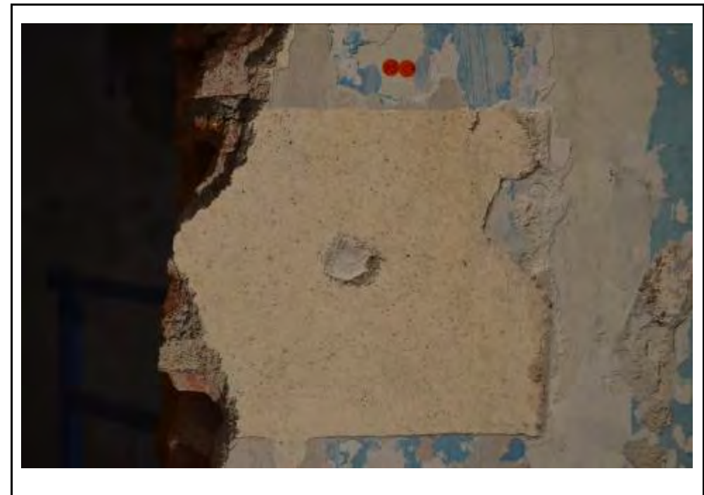
Cala 7 al mur A3
