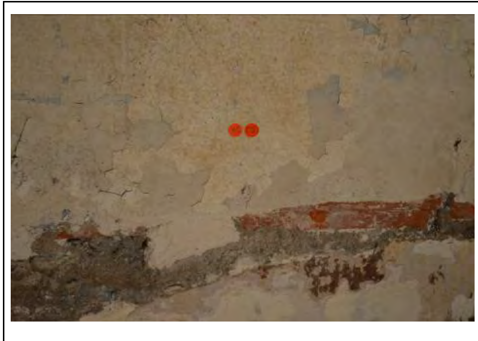
Cala 5 al mur A2
