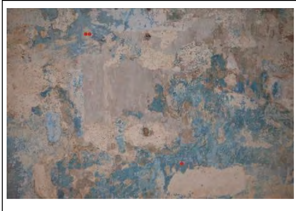
Cala 2 al mur A1. El morter original és de tonalitat blavosa
