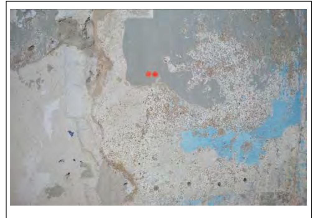
Cala 16 al mur C3
