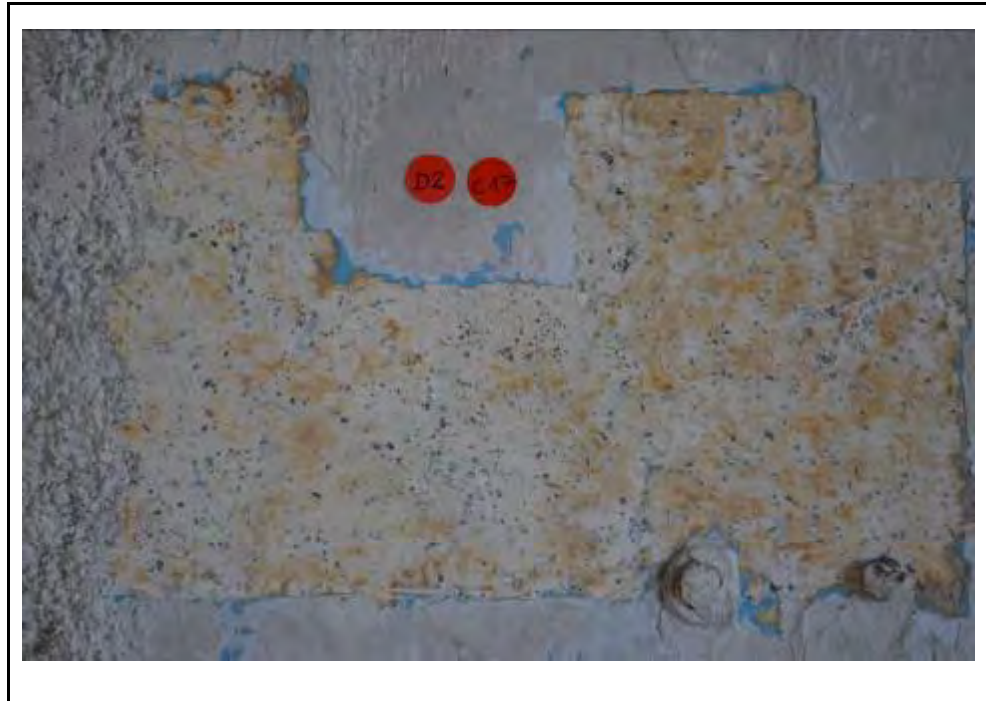
Cala 17 al mur D2
