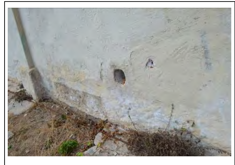
C3-02. Orifici de desguàs de la latrina
