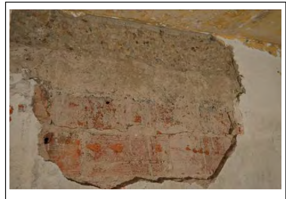
Detall dels totxos i la jàssera superior de formigó
