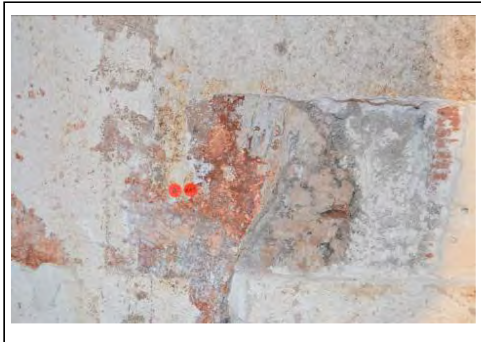
Cala 11 al mur B2. Realitzada per esbrinar les dimensions de l'obertura en aquest punt
