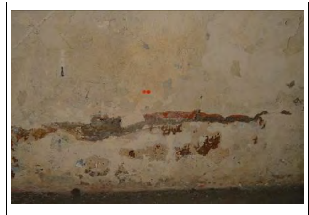
Cala 5 al mur A2. Es va poder constatar l'obertura d'època barraquista
