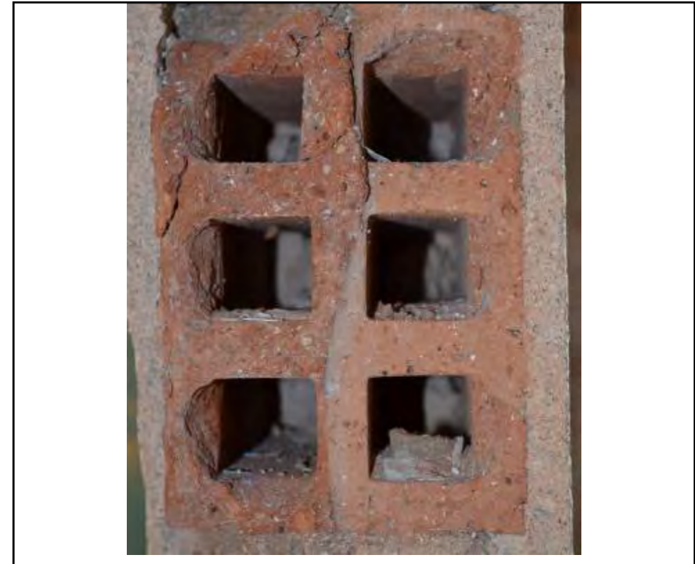
Interior del totxo utilitzat durant la Guerra Civil per a la construcció del pavelló
