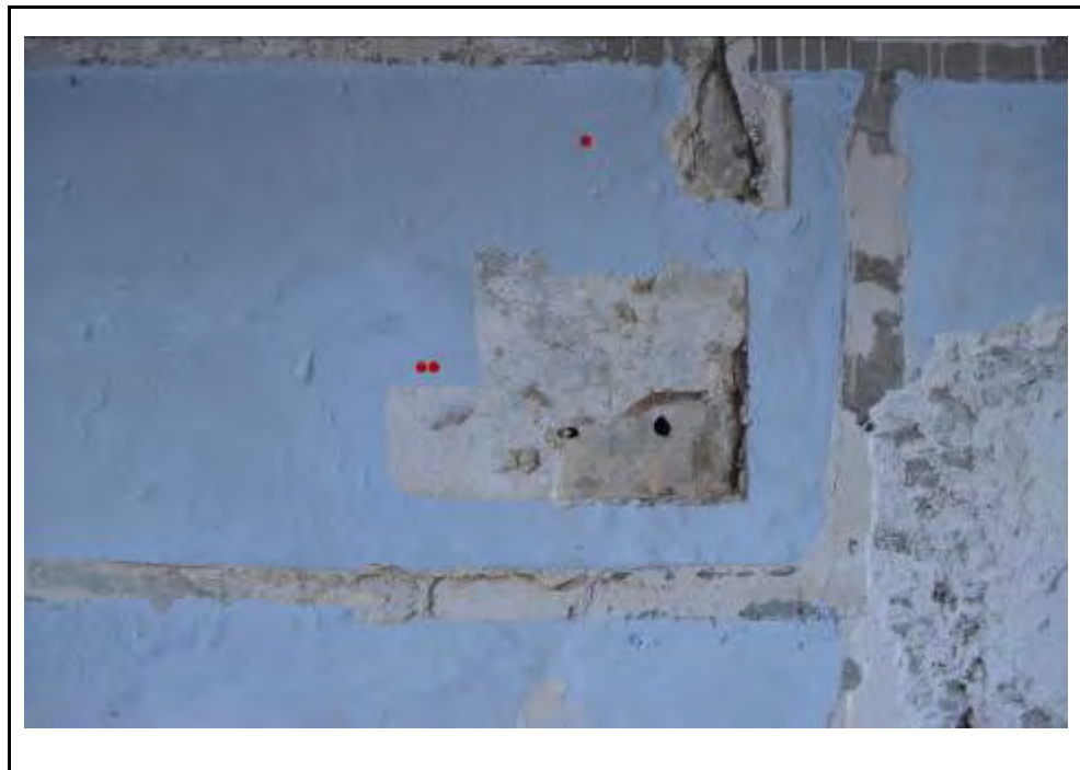
Cala 14 al mur C2
