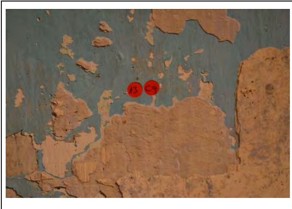
Cala 9 al mur A3
