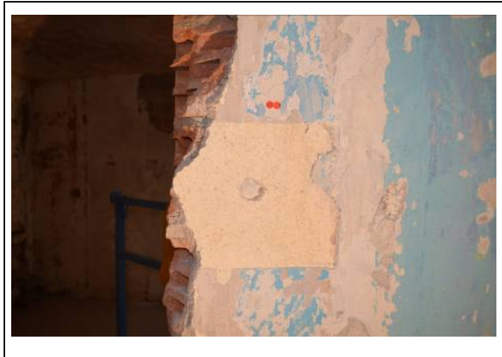
Cala 7 al mur A3
