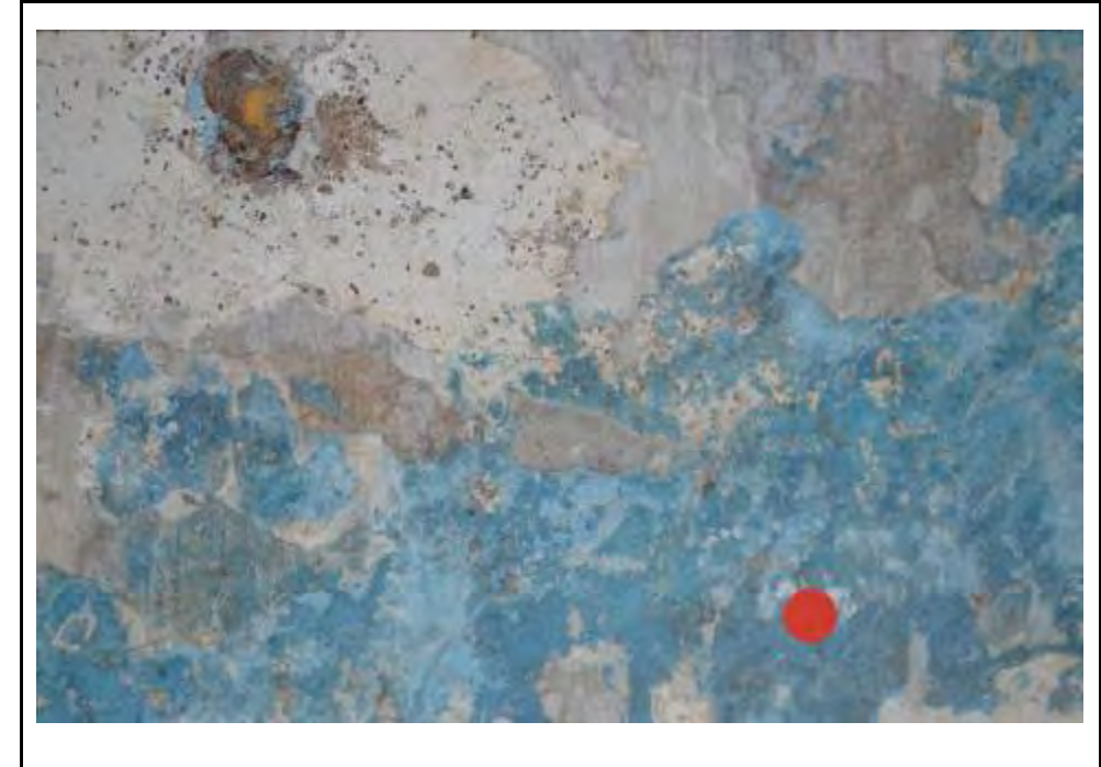
Cala 2 al mur A1
