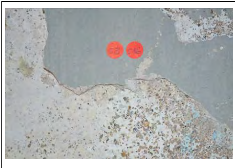
Cala 16 al mur C3. Detall del morter en blanc a la paret superior del lavabo
