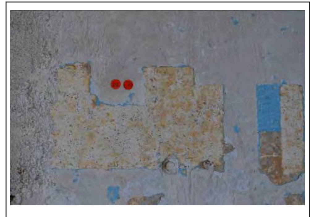
Cala 17 al mur D2. Aquesta cala va servir per veure que la capa en groc era l'original en aquest habitacle utilitzat com a cuina
