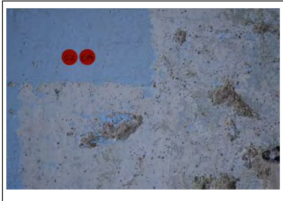
Cala 14 al mur C2
