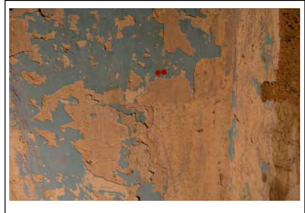
Cala 9 al mur A3
