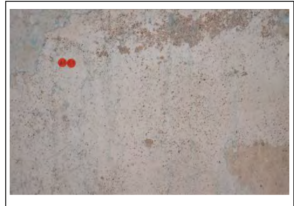
Cala 3 al mur A1
