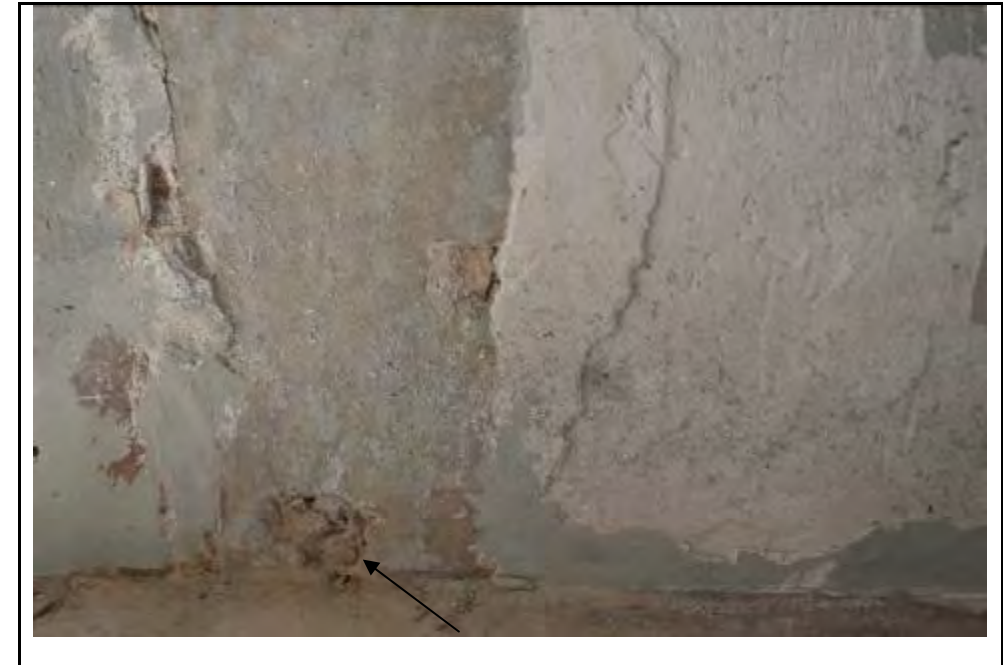
C3-02. Orifici de desguàs de la latrina
