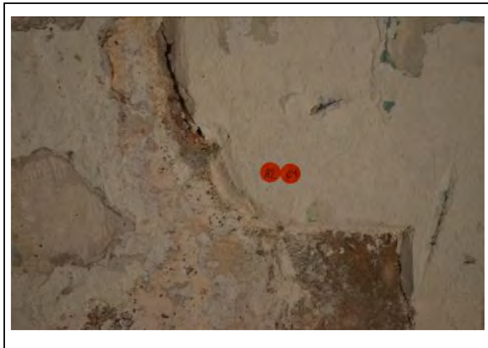
Cala 4 al mur A2. Es va poder constatar l'obertura d'època barraquista
