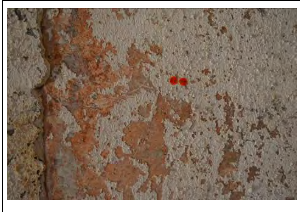
Cala 10 al mur B1
