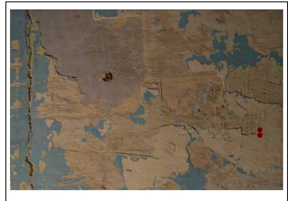
Cala 8 al mur A3
