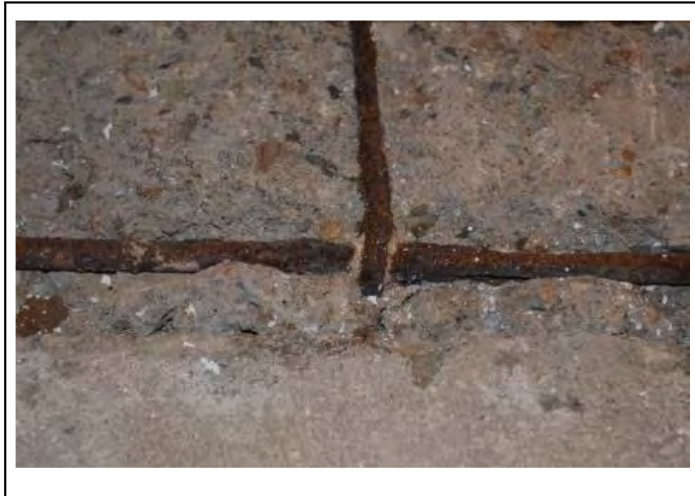
Detall del ferro utilitzat al formigó de les jàsseres superiors
