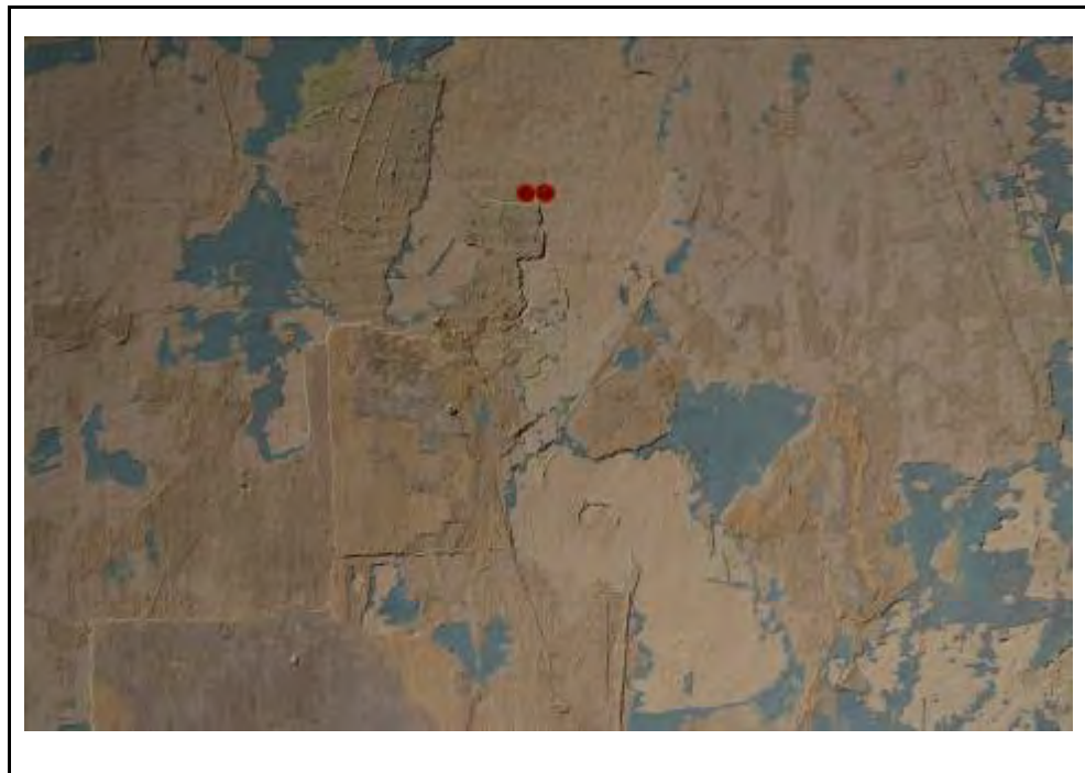
Cala 8 al mur A3
