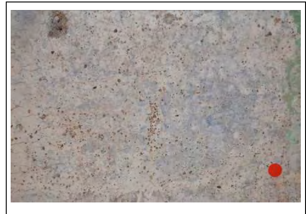
Cala 1 al mur A1
