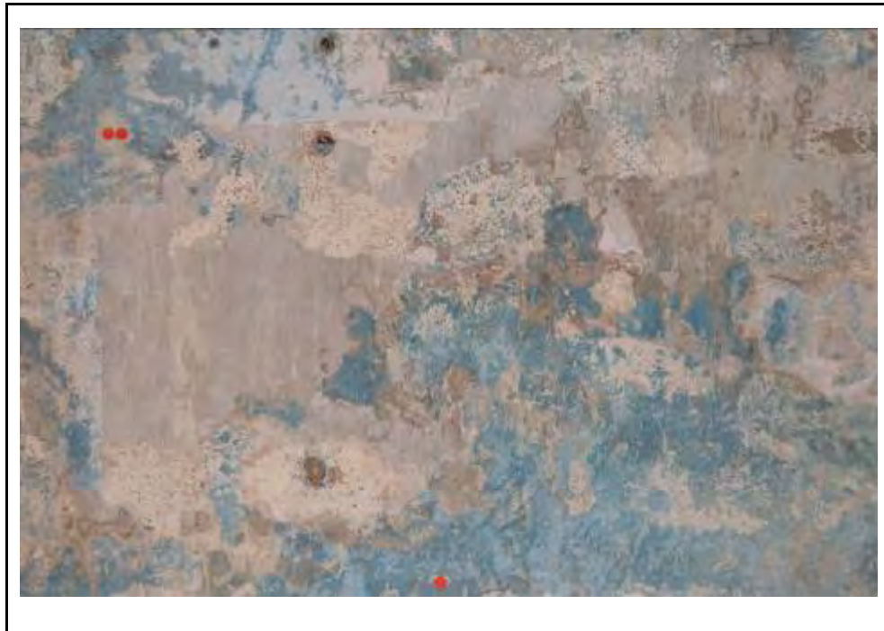
Cala 2 al mur A1
