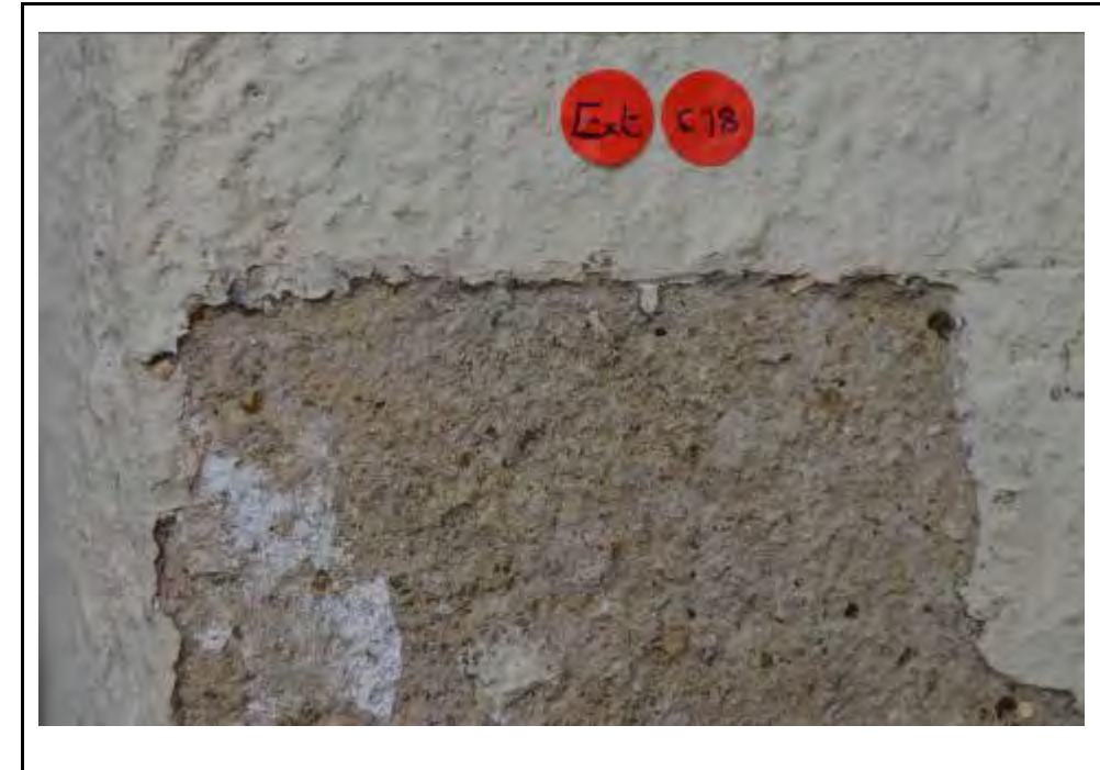
Cala 18 a l'exterior a tocar a la porta actual d'accés
