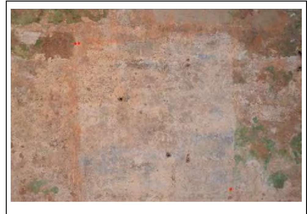
Cala 1 al mur A1
