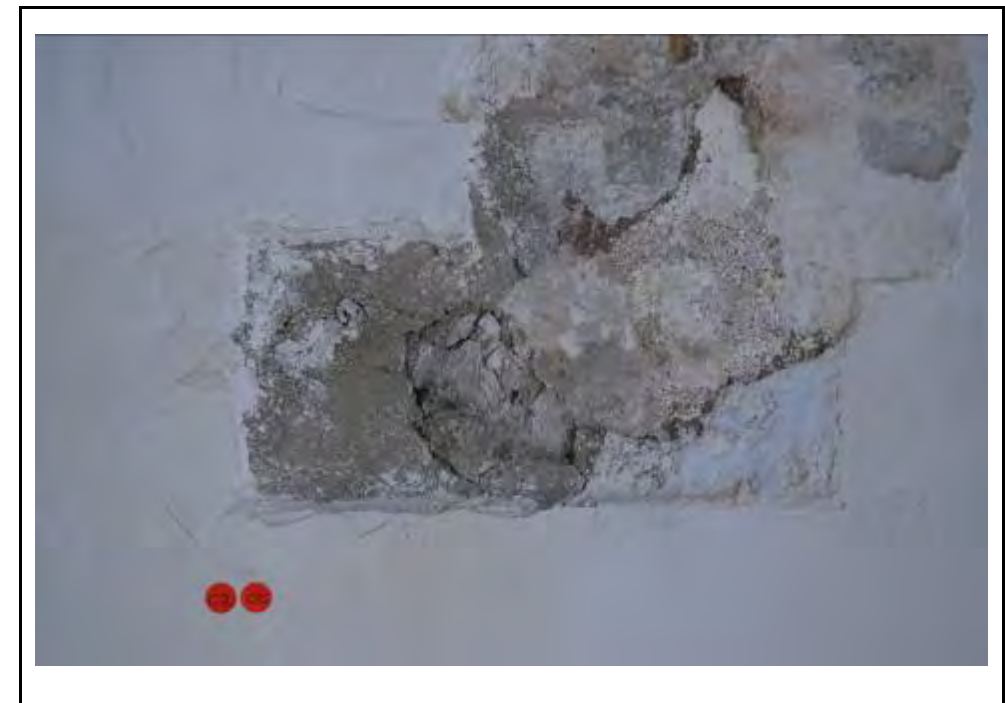
Cala 15 al mur C2
