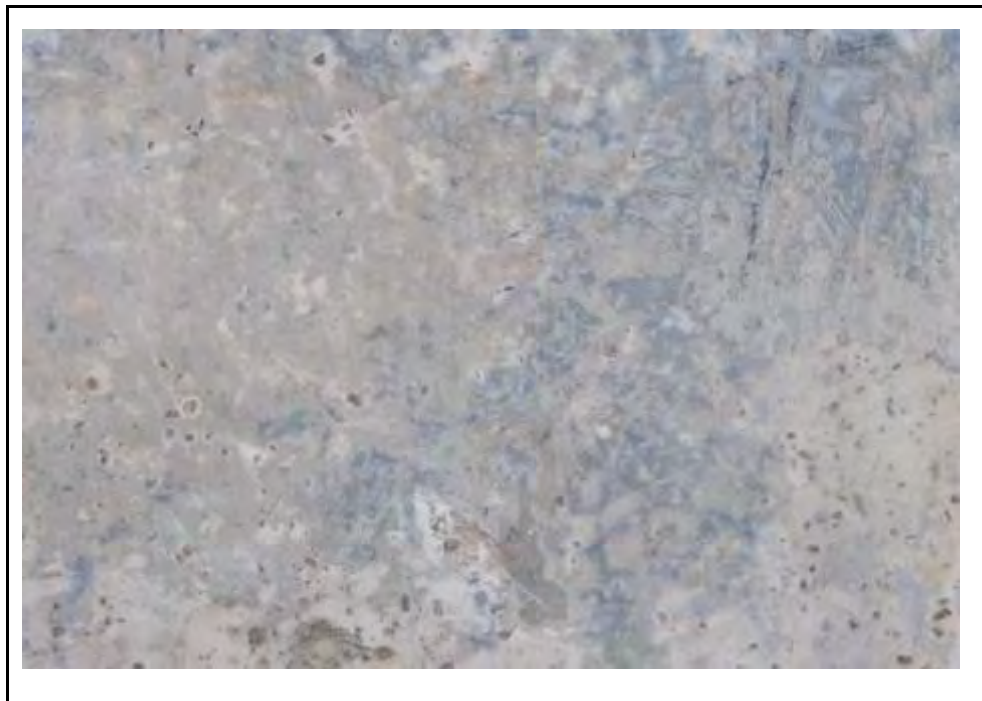
Detall de la tonalitat en blau, pintura original aplicada durant la Guerra Civil espanyola. Es pot veure el morter blanc de base amb desgrent visible.
