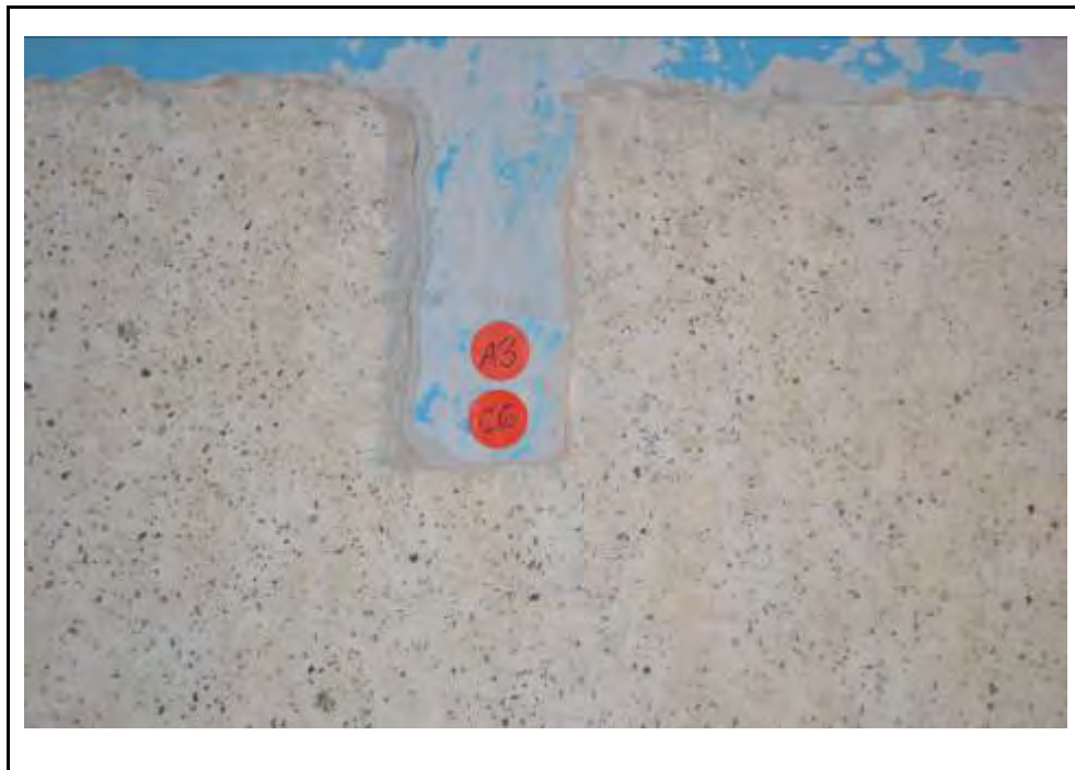
Cala 6 al mur A3. Detall del morter amb desgreixant visible sense la capa blavosa
