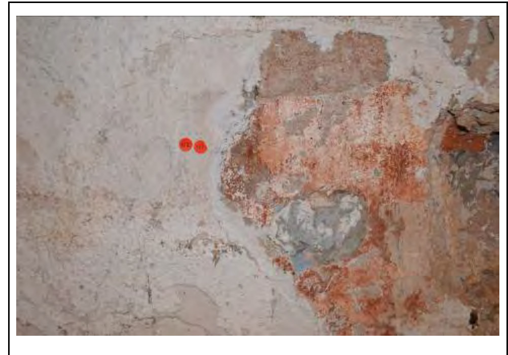
Cala 12 al mur B2. Realitzada per esbrinar les dimensions de l'obertura en aquest punt
