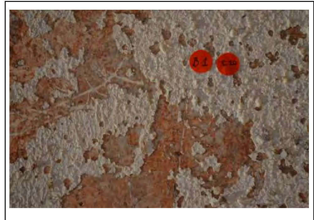
Cala 10 al mur B1. Detall del vermell utilitzat amb una capa d'estuc blanc d'època de l'escola d'adults
