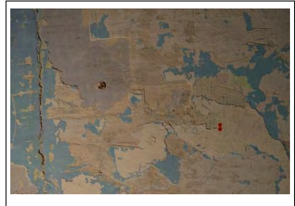
Cala 8 al mur A3
