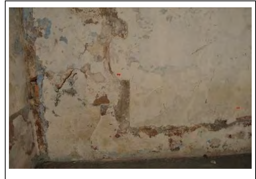
Cala 4 al mur A2
