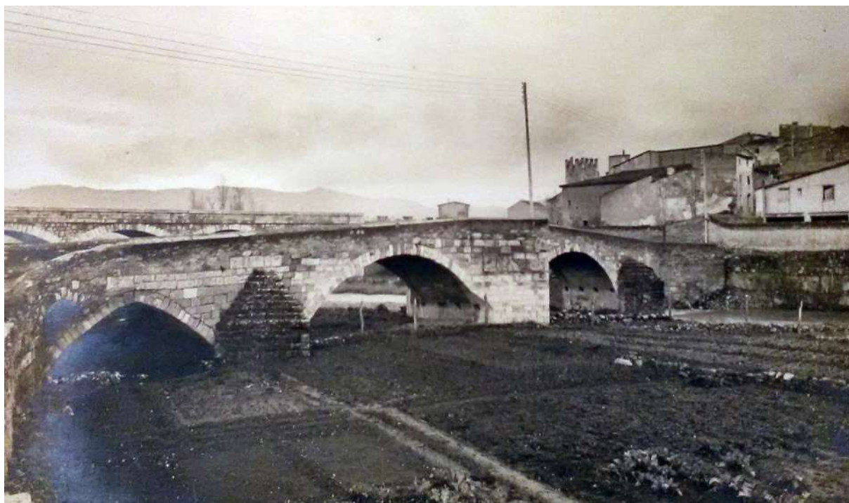
Fig. 2: Fotografia antiga del pont aigües amunt. 1918. S'observa la configuració original de la primera arcada, destruïda durant la Guerra Civil (Fons Fotogràfic SPAL, Arxiu SCCM, clixé 10068).
