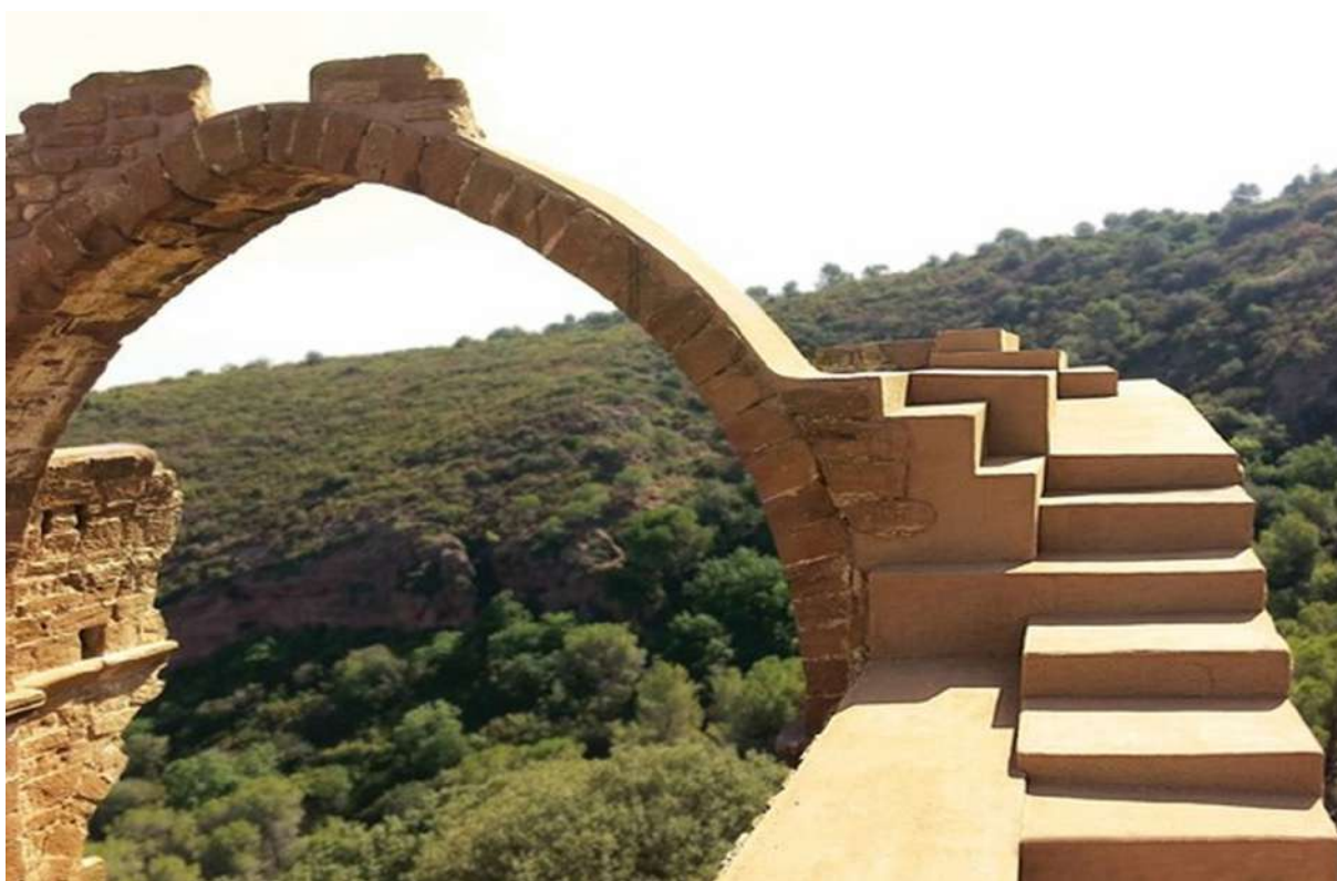
Fig. 5: Consolidació de l'arc toral de l'església de Sant Genís.
