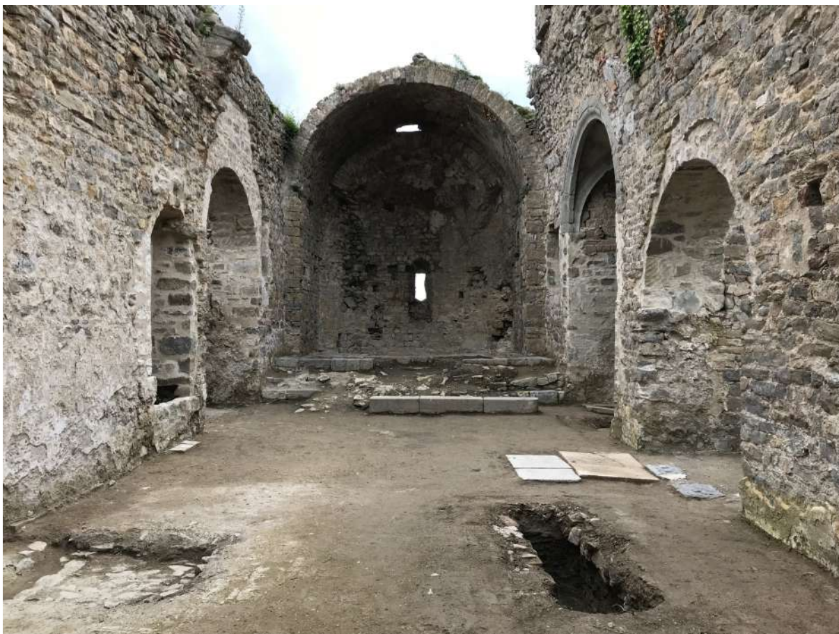
Fig. 4: Vista de la nau central de Santa Maria, després de les tasques de desenrunament i consolidació dels arcs (Font: ATICS SL).
