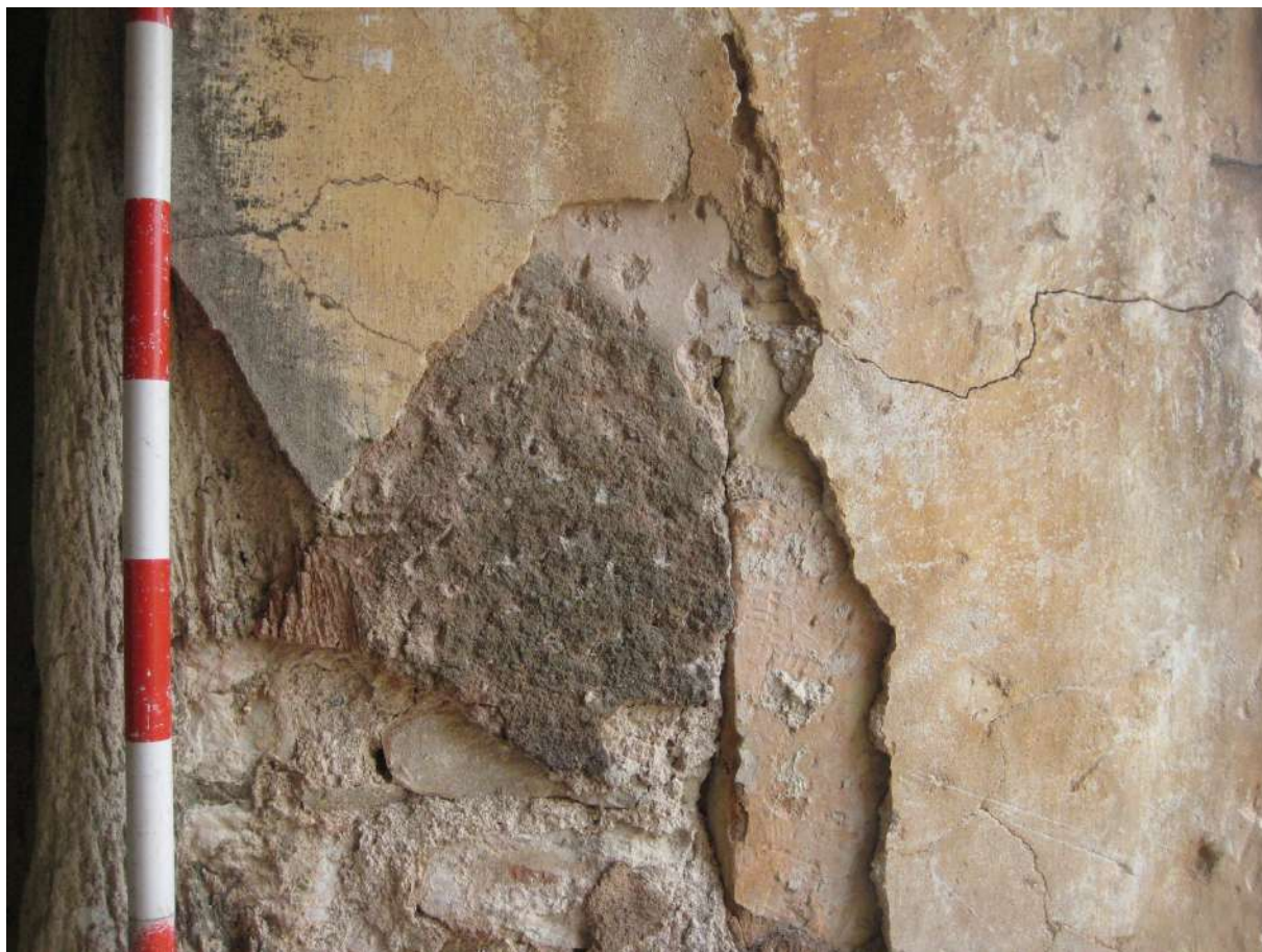
Fig. 3: Detall de seqüència estratigràfica parietal de revestiments continus. Castell de Rodonyà (Rodonyà, Alt Camp) (Fotografia: I. Pastor).
