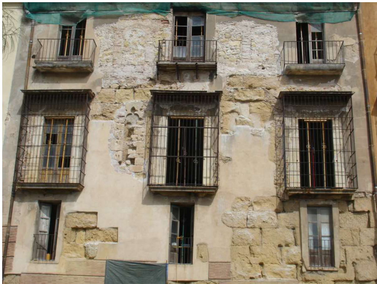
Fig. 6: Estat final del parament exterior de la muralla que dona al passeig de Sant Antoni, una vegada finalitzada l'actuació, carrer Granada 7 (Némesis Arqueologia i difusió cultural).
