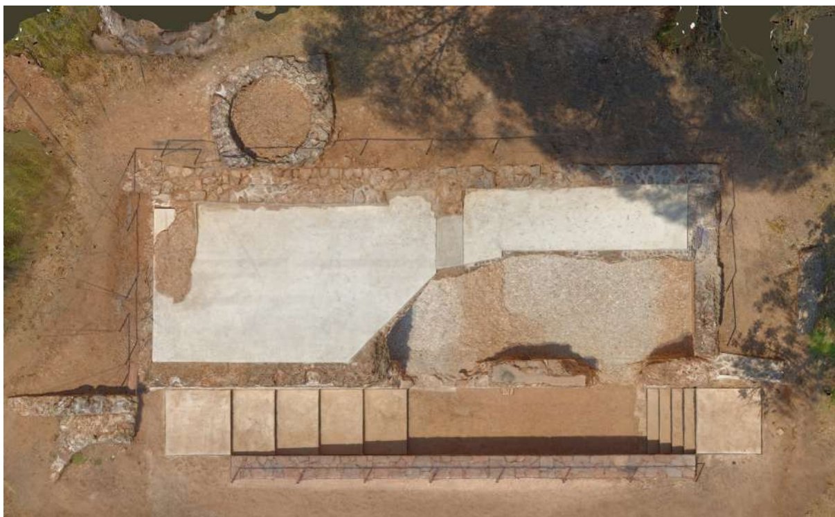
Fig. 4. Vista aèria de l'element un cop enllestits els treballs de consolidació (Fotogrametria: Pau Majó. Arxiu SPAL).
