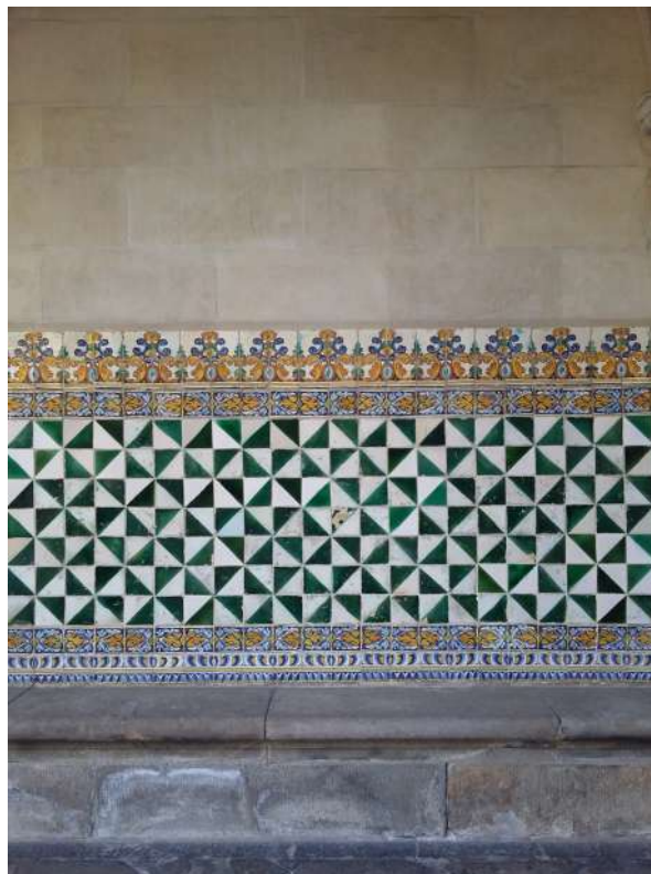
Fig.1: Arrambadors de ceràmica esmaltada (segona meitat segle XVII). Pati de la Casa de Convalescència. Antic Hospital de la Santa Creu. (Barcelona). (Fotografia: I. Pastor)
