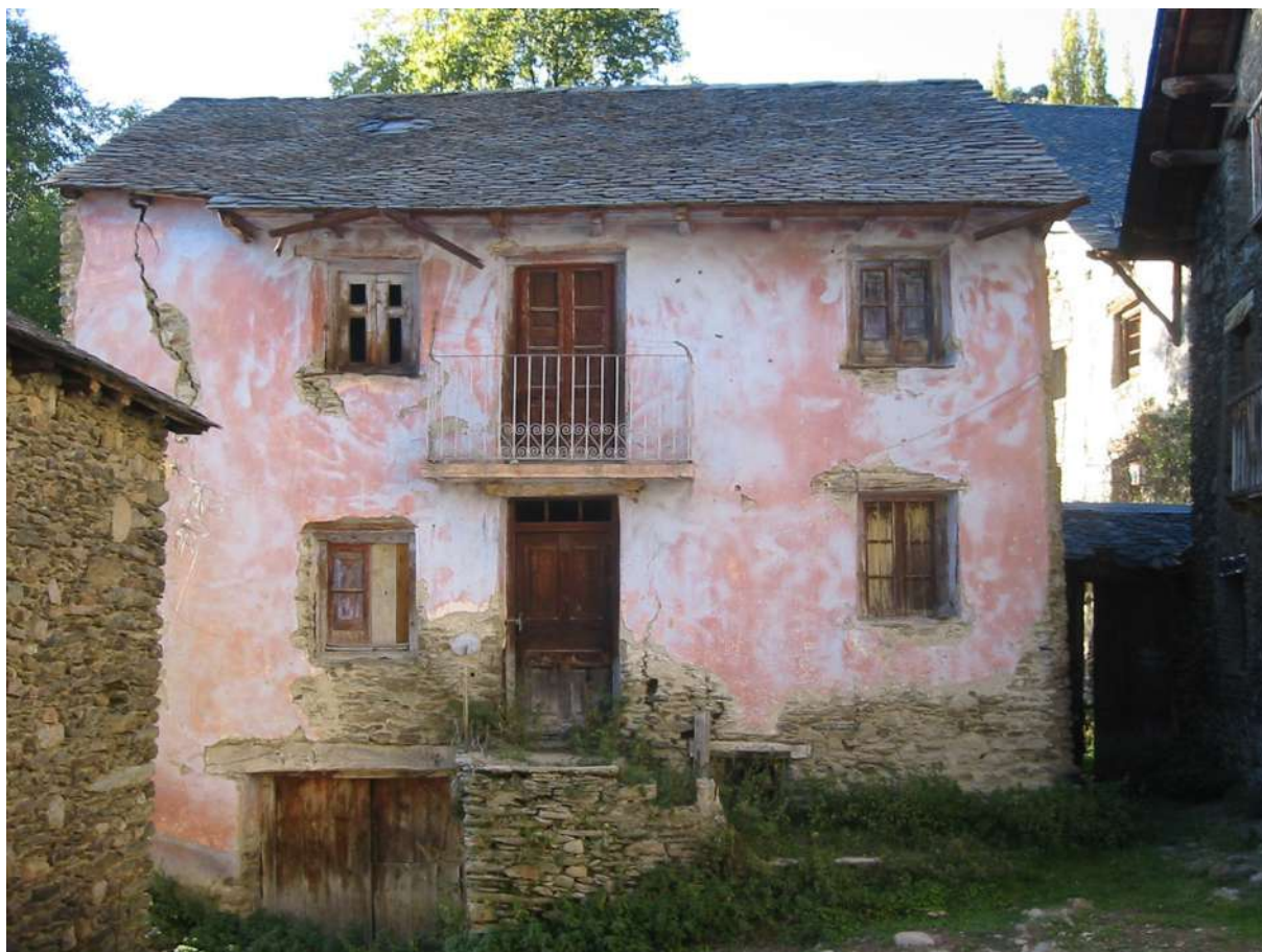
Fig. 4: Façana amb arrebossat de morter de calç pigmentat (Dorve, Pallars Sobirà) (Fotografia: I. Pastor).
