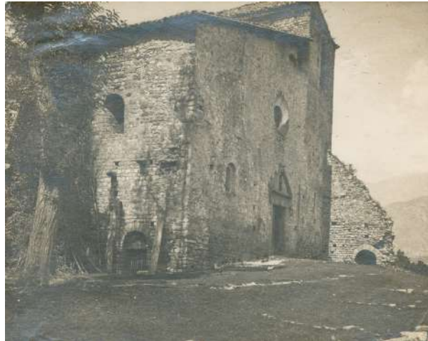
Fig. 1a: La façana principal de l'església des del sud-est, l'any 1921 (Fotografia: J. Ribera. Arxiu SCCM-SPAL).
