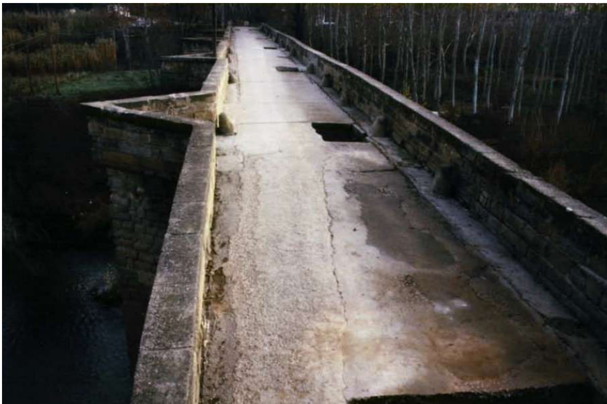
Fig. 2: Vista general del Pont Nou, en el decurs de l'execució dels treballs d'excavació (Anna Gómez Bach).
