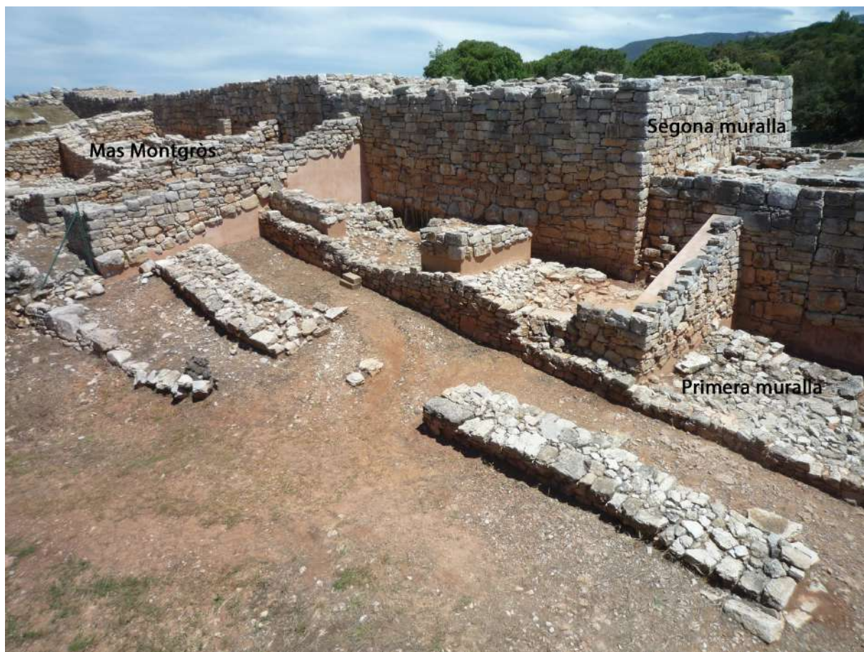
Fig. 4: Vista des del sud-oest del traçat de la primera muralla ibèrica (s. V aC) i just al darrere la segona muralla (s. III aC). S'observen també les ruïnes d'una edificació d'època ibèrica i d'un mas medieval ambdós adossats a la segona muralla i assentats sobre els vestigis de la primera (Fotografia: Cecília Sanjurjo Marquine, 2014. Arxiu SPAL).
