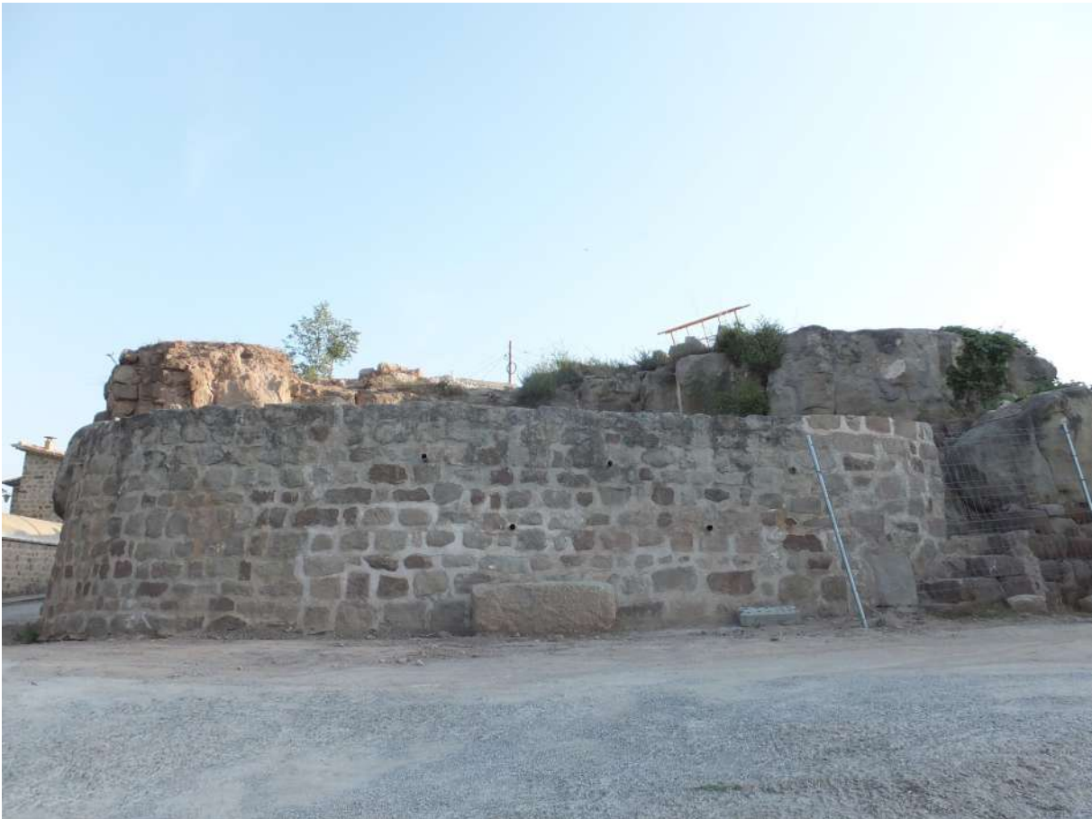
Fig.1: Mur de tancament de ponent, després de l'extracció de la caseta de telecomunicacions i de la plataforma de formigó, Juliol de 2015 (Fotografia: Eudald Serra).
