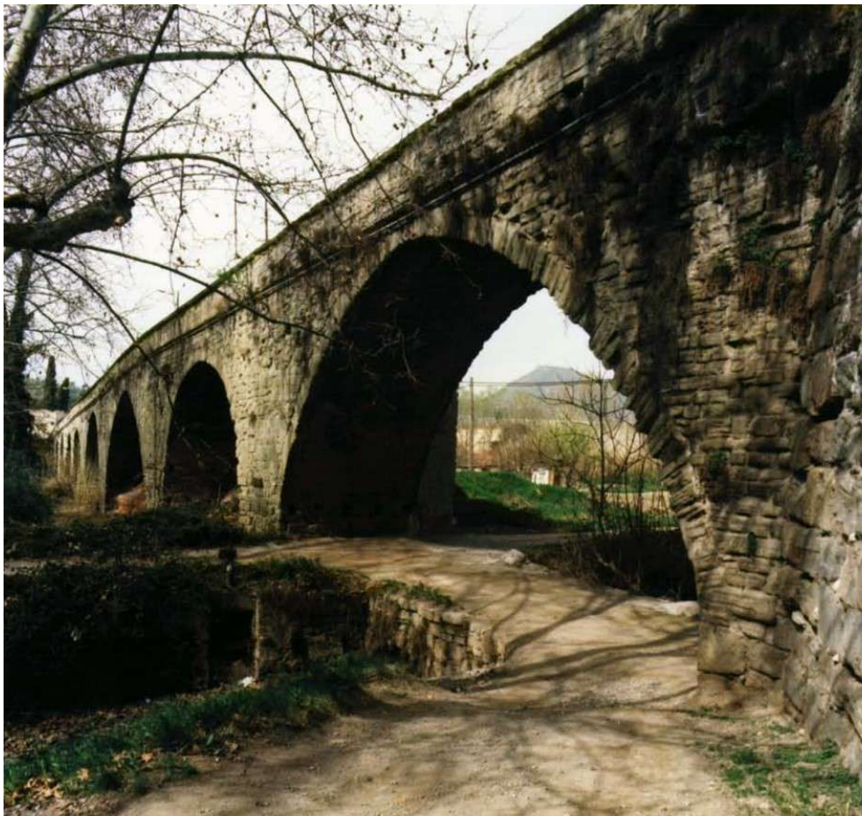
Fig. 1: Imatge dels paraments del pont aigües amunt (Anna Gómez Bach).
