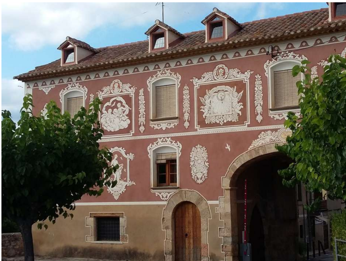
Fig. 2: Esgrafiats de la façana sud de l'edifici del portal d'accés al primer recinte. Plaça de Santa Llúcia. Monestir de Santes Creus (Aiguamúrcia, Alt Camp) (Fotografia: I. Pastor).
