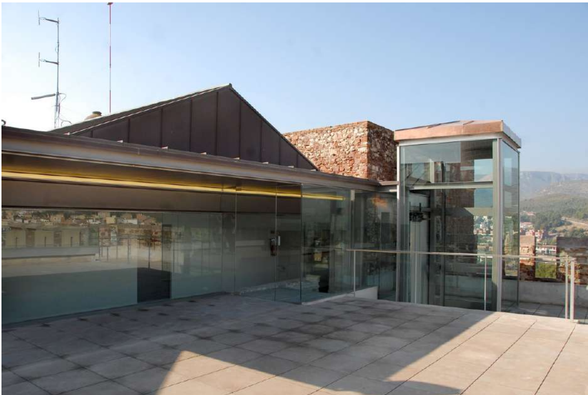
Fig. 5: La terrassa mirador del castell amb l'arribada de l'ascensor panoràmic (Fotografia: Montserrat Baldomà, 10 de febrer de 2011. Arxiu SPAL).
