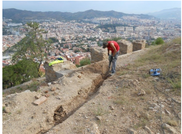
FOTO 22. Excavació de rases en la zona "dormitoris de la tropa"
