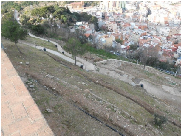
FOTO 29. Rases de serveis a la vessant sud del turó- camí nord i camí oest baix
