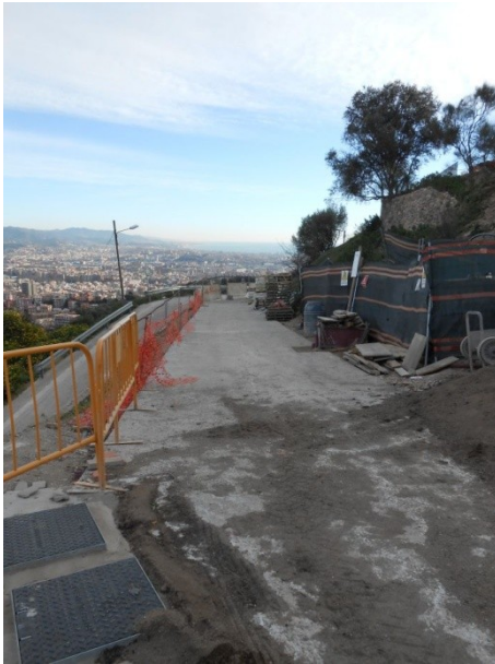
FOTO 37. Estat final de l'accés al turó
