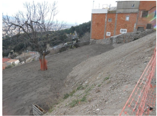
FOTO 20. Estat final de la zona E2
