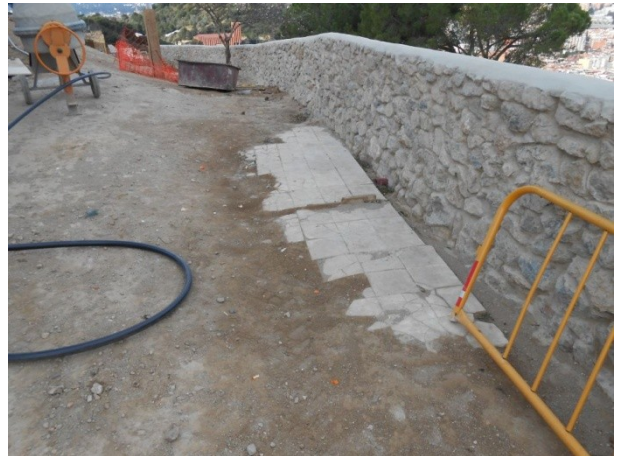
FOTO 38. Detall del paviment localitzat en la confluència de la zona E1 i el camí del carrer del Turó de la Rovira – Dormitoris de la tropa
