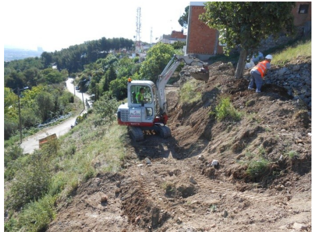
FOTO 26. Rebaixos per a la reconstrucció dels murs a la zona E2
