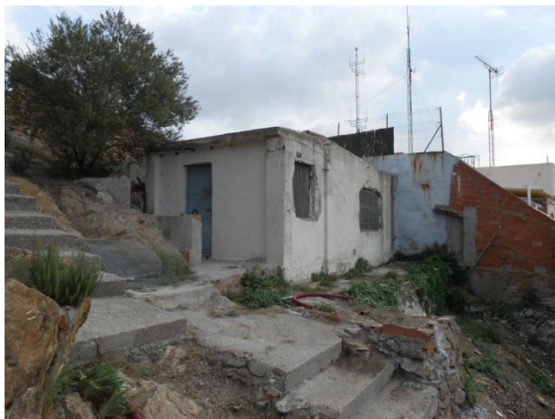
FOTO 27. Detall del Pavelló dels oficials
