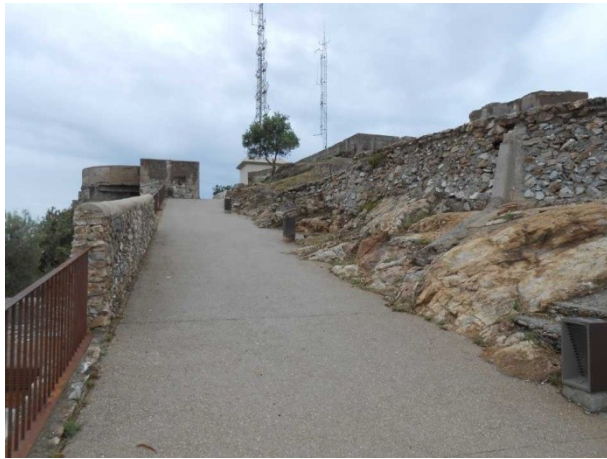
FOTO 5. Carrer principal del complex de bateria antiaèria i nucli barraquista. Direcció oest
