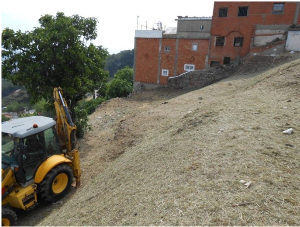
FOTO 17. Estat inicial de la zona E2
