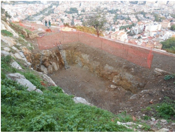
FOTO 19. Dipòsit excavat a la zona E2
