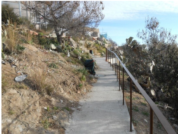
FOTO 39. Estat final de camí oest baix
