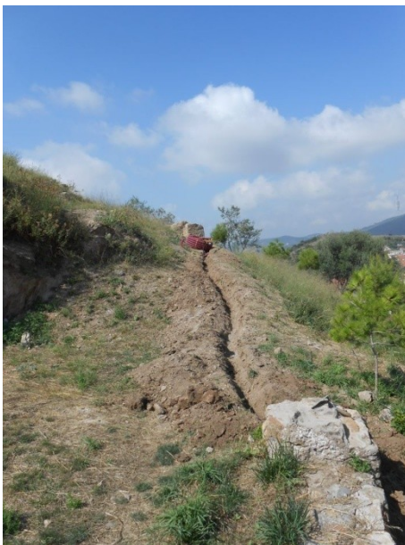
FOTO 23. Rases de serveis al "camí nord"
