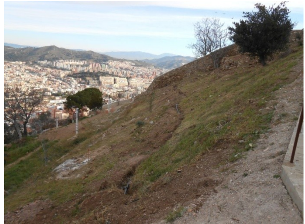
FOTO 30. Rases de serveis a la zona del "camí oest alt"
