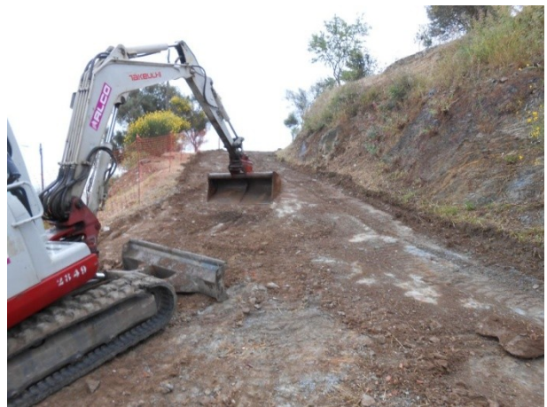
FOTO 32. Tasques de rebaix al camí carrer del Turó de la Rovira – Dormitoris de la tropa
