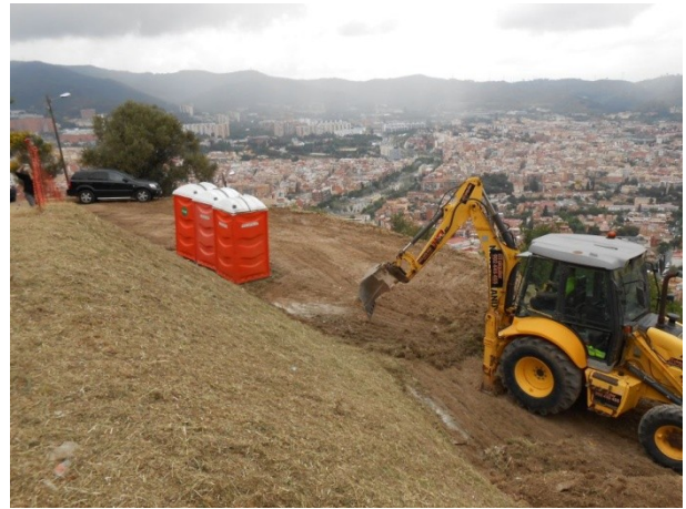
FOTO 18. Rebaix de la zona E2
