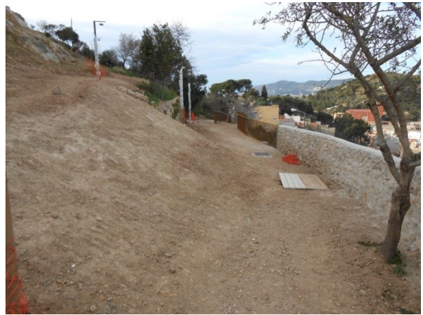
FOTO 16. Estat final de la zona E1
