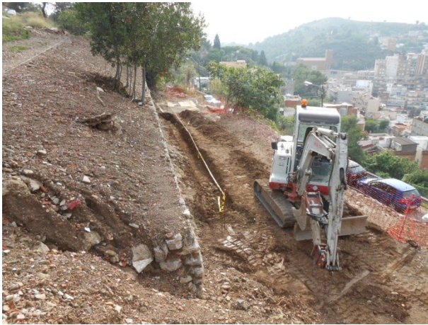
FOTO 15. Rasa de serveis a la zona E1
