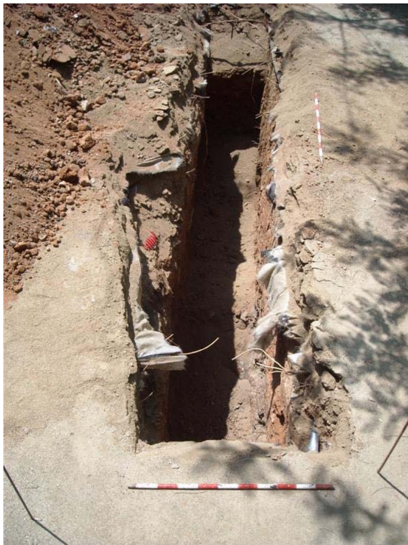
Fig. 10. Vista general del sondeig 300.
