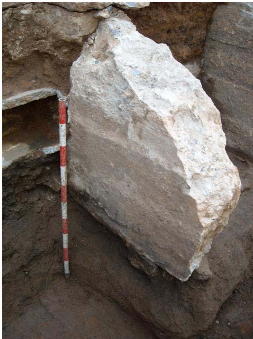
Fig. 7. Detall del mur UE: 107 amb les empremtes de l'encofrat.
