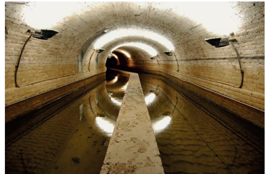
Galería central de la mina de Montcada. Interior del primer tramo de la galería de las minas de Montcada, vista desde el punto de observación en el sótano de la casa del guarda. El conjunto lo conforman 2.350 metros de galerías subterráneas de captación por filtración del acuífero del Besòs y de conducción hasta el Reixegó, MUHBA.
