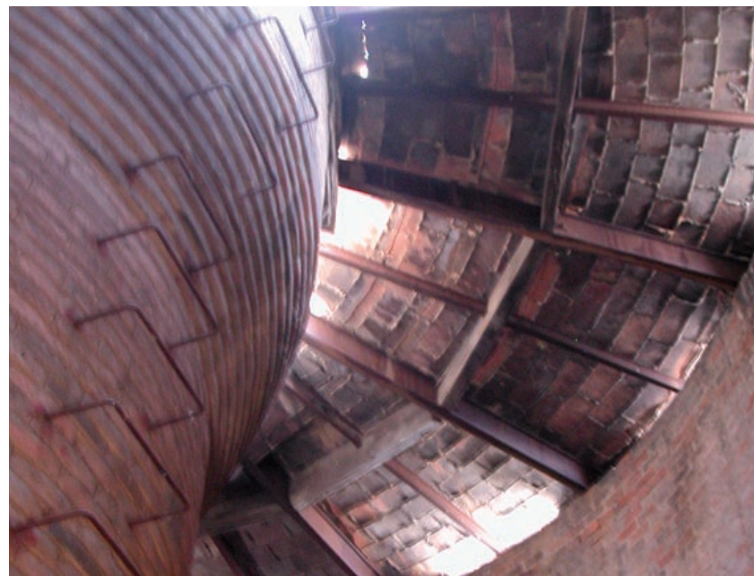
Estado de la cubierta antes de la rehabilitación.
