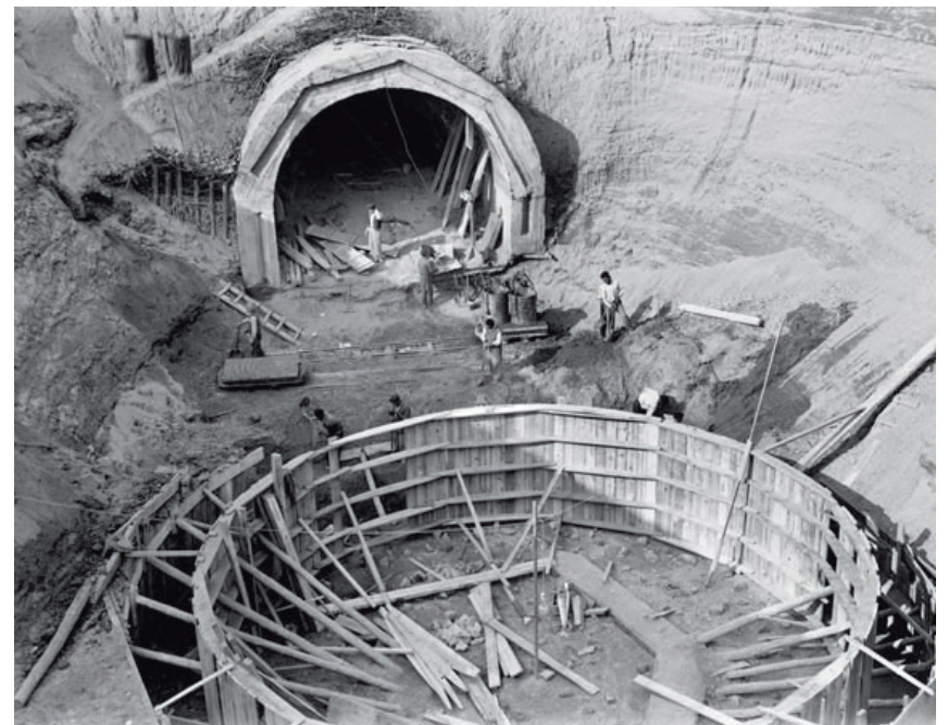
Obras de construcción de la Estación de Aguas Superficiales de la SGAB en Sant Joan Despí, 1953-1954, Fundación AGBAR.
