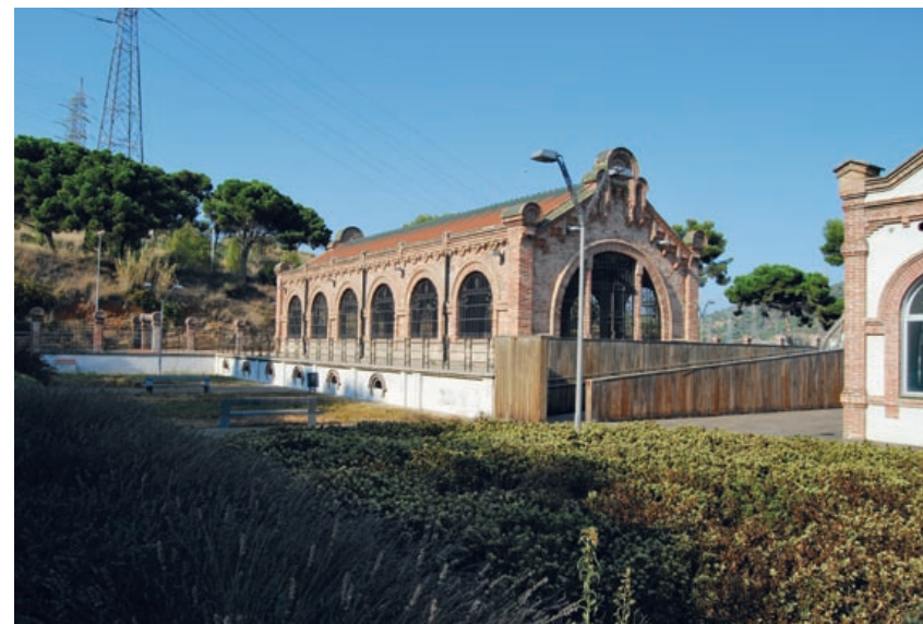
Vista de conjunto del exterior del depósito municipal de primera elevación. El recinto se conoce también como Casa de las Aguas de Trinitat Nova. En la imagen se aprecian el exterior de la sala de aforo, una parte de la zona superior del depósito de primera elevación con la verja exterior de fondo y a la derecha la caseta del guarda, situada en el mismo eje de la sala de aforo, MUHBA.
