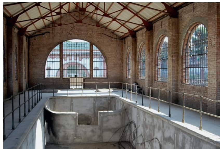
Interior de la sala de aforo del depósito de Trinitat Nova. Sala del depósito de aforo abierto, al que llegaba el agua desde la tubería de impulsión de 50 centímetros procedente de la estación elevadora antes de entrar en los compartimentos del depósito. Se encuentra sobre el eje transversal del depósito y sus características arquitectónicas son similares a las de la sala de máquinas de la estación elevadora, MUHBA.
