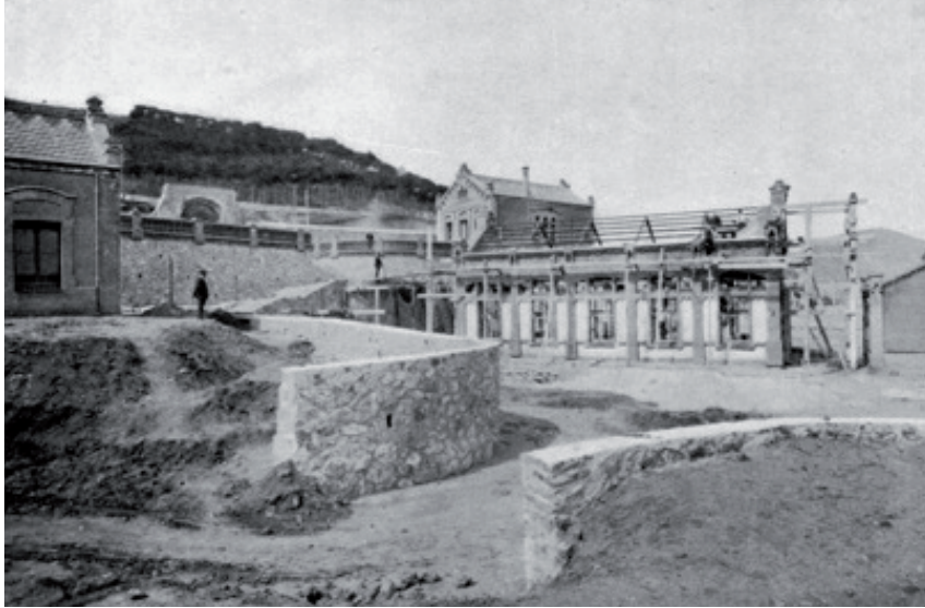
Estación elevadora de Trinitat Vella en construcción en 1917. A la izquierda se distingue una parte del edificio destinado a oficinas y almacén; en el centro, la sala que debía alojar las tres electrobombas elevadoras; a la derecha se contempla parcialmente la sala de distribución; y al fondo, la casa del guarda, al lado de la entrada del recinto, junto a la carretera de Ribes. Gaceta Municipal de Barcelona , 1917, Ayuntamiento de Barcelona, АНСВ.
