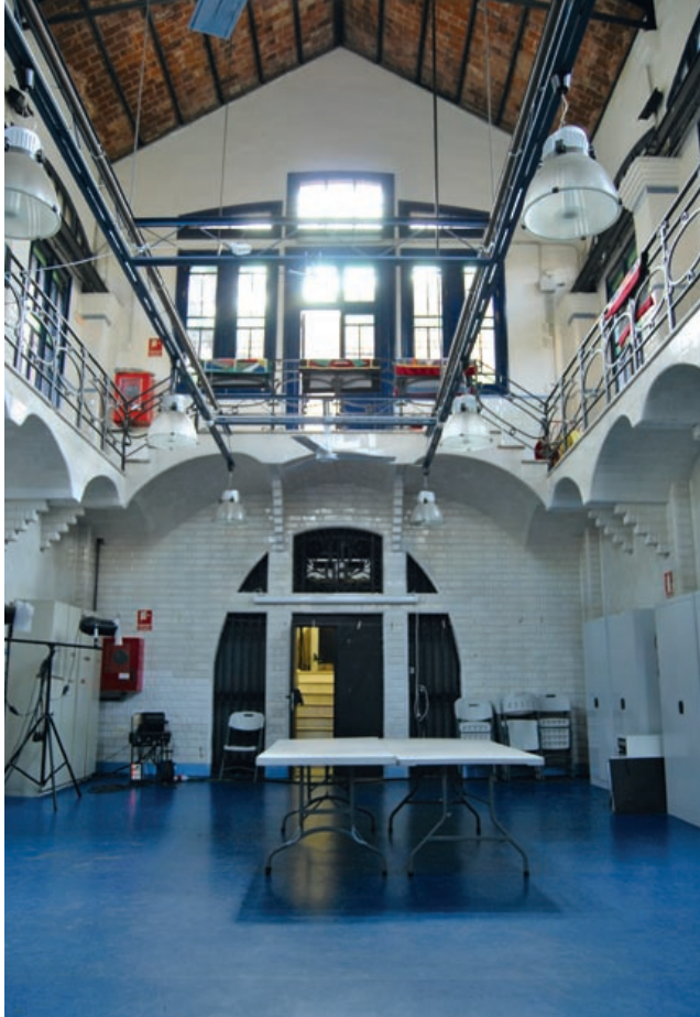
Interior de la sala de máquinas electrobombas de la central elevadora, remodelada desde el año 2007, МУНБА. Podía alojar cuatro electrobombas, pero sólo se instalaron tres. Elevaban diariamente unos 21.000 metros cúbicos al depósito de primera evaluación de Trinitat Nova.
