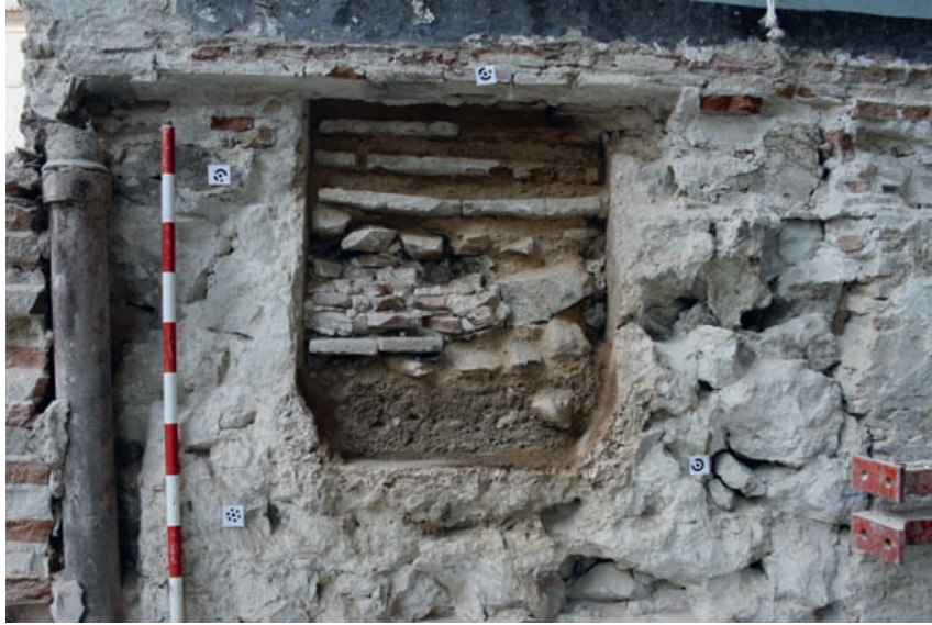
Sección del acueducto donde se observa el specus de opus signinum (fotografía: Vanesa Triay – Àtics).
