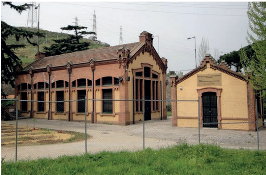
Vista actual del exterior de la Casa de las Aguas de Trinitat Vella. A la izquierda, la sala de máquinas electrobombas de elevación y, a la derecha, la sala de distribución, a la que llegaba el agua procedente de Montcada. A partir de 2006 se han rehabilitado estos dos edificios y actualmente se pueden visitar, junto con el primer tramo de la galería del acueducto Alt de Montcada (fotografía: M. Martín Pascual).
