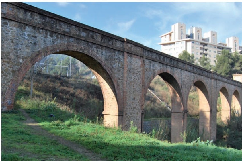
Acueducto de Dosrius en Torre Baró, MUHBA.
