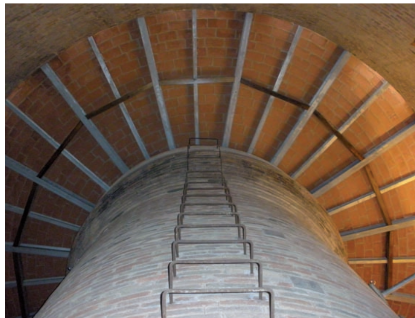
Imagen de la cubierta una vez ya rehabilitada.
