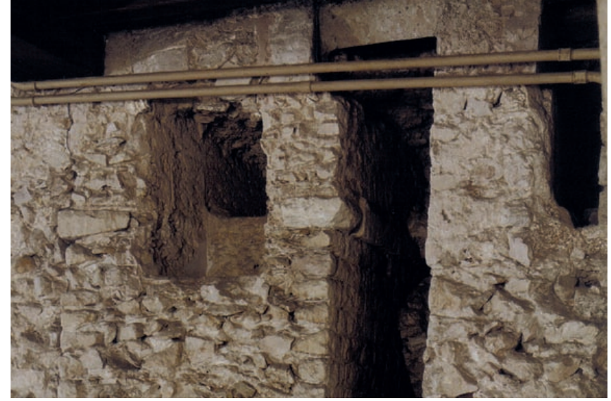
Sección de los acueductos a su entrada a la ciudad por la torre de la Casa de l'Ardiaca (fotografía: Núria Miró).
