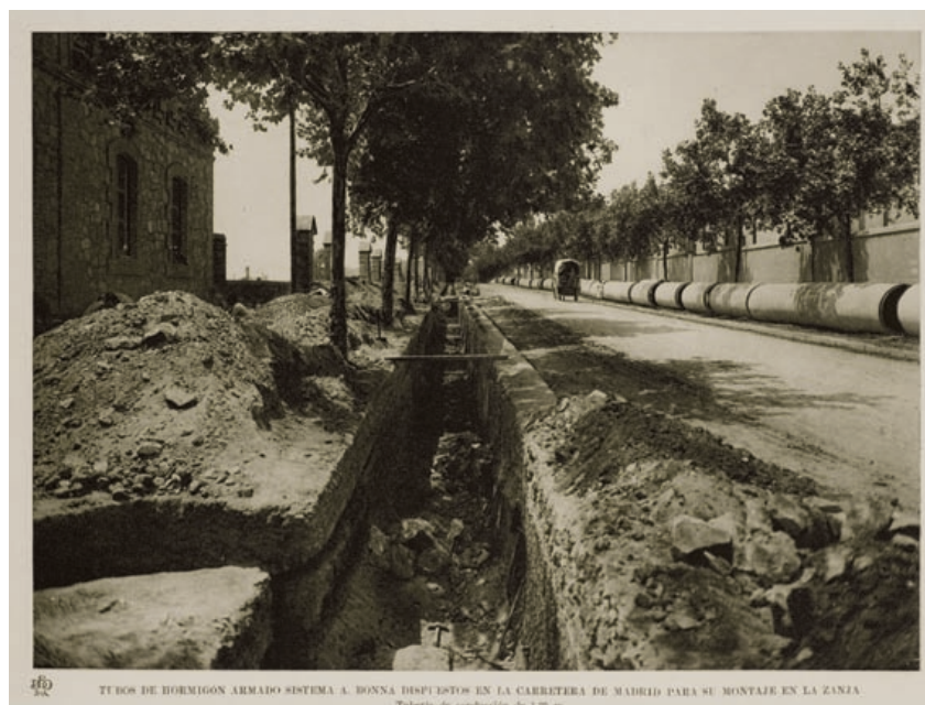
Instalación de los tubos de hormigón armado en la zanja de la carretera de Madrid, 1925, SGAB.
