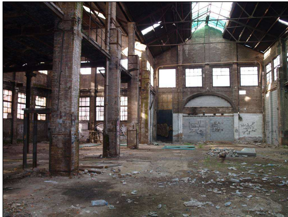
Accés principal des del carrer Espronceda (vistes exterior i interior).
