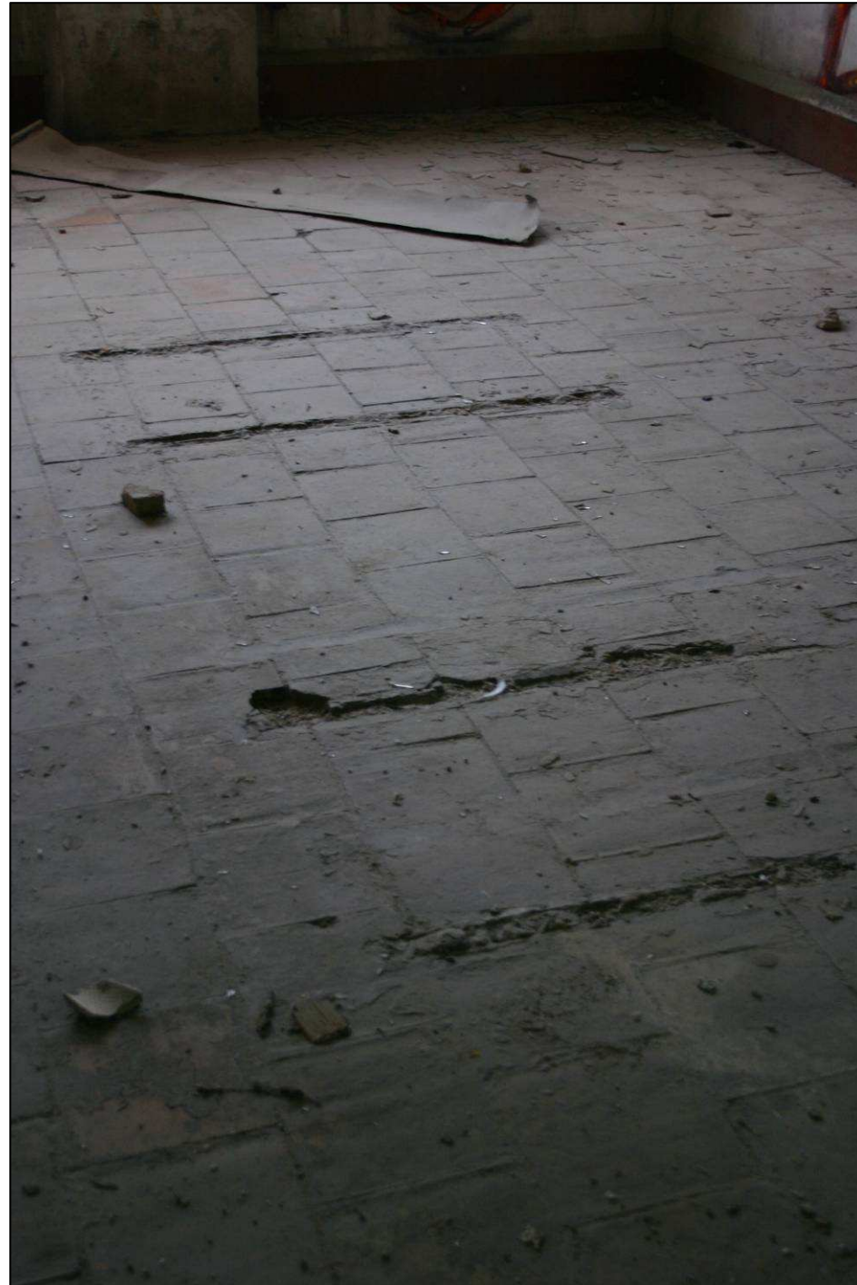
Marques d'anclatges d'una màquina de la planta pis de la nau oest.
