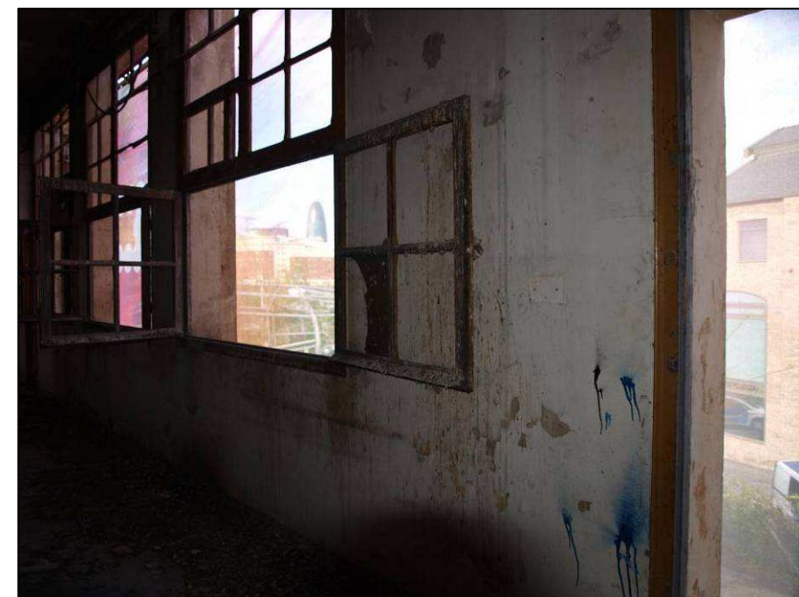
Vista de les finestres (sud-est i oest planta pis).
