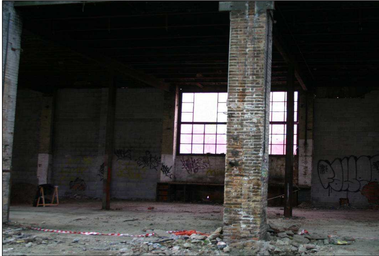
Mur oest de la nau lateral (sud-oest i nord-oest).
