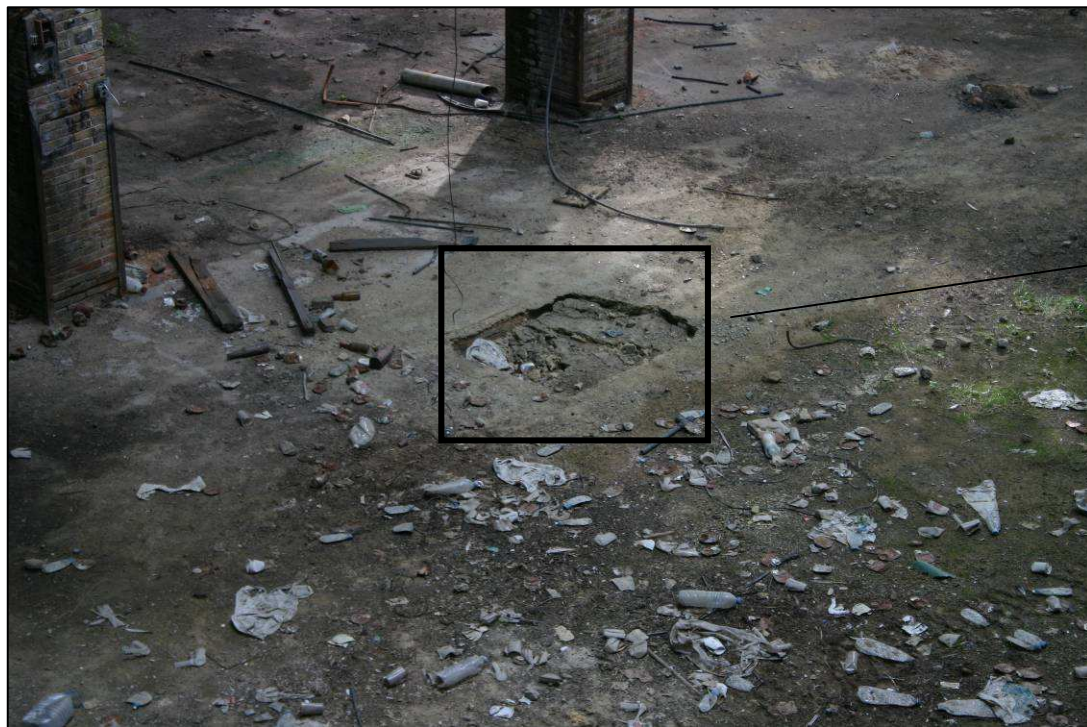
Cavitat per a maquinària (nau central: nord-oest i sud-est i emplaçament d'aquestes.
