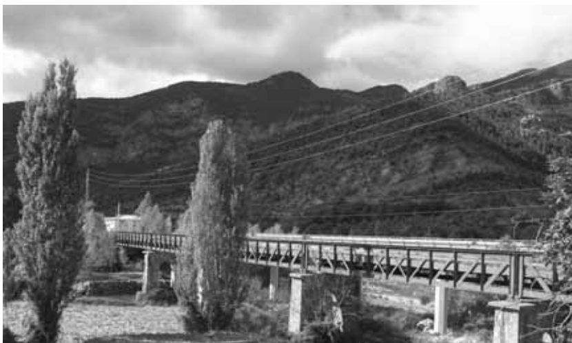
Pont a Morilla de Liena, Osca, amb estructura de ferro recuperada de la bastida del monument a Colom
