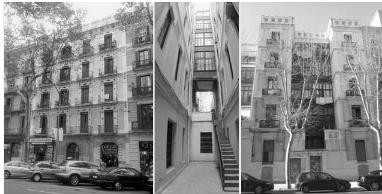
Estat actual de la Casa Torras Guardiola: façana principal a la ronda de Sant Pere (esquerra), i pati interior i galeria de la casa número 70, mirant cap al carrer de Trafalgar (centre) i façana posterior al carrer de Trafalgar (dreta)
