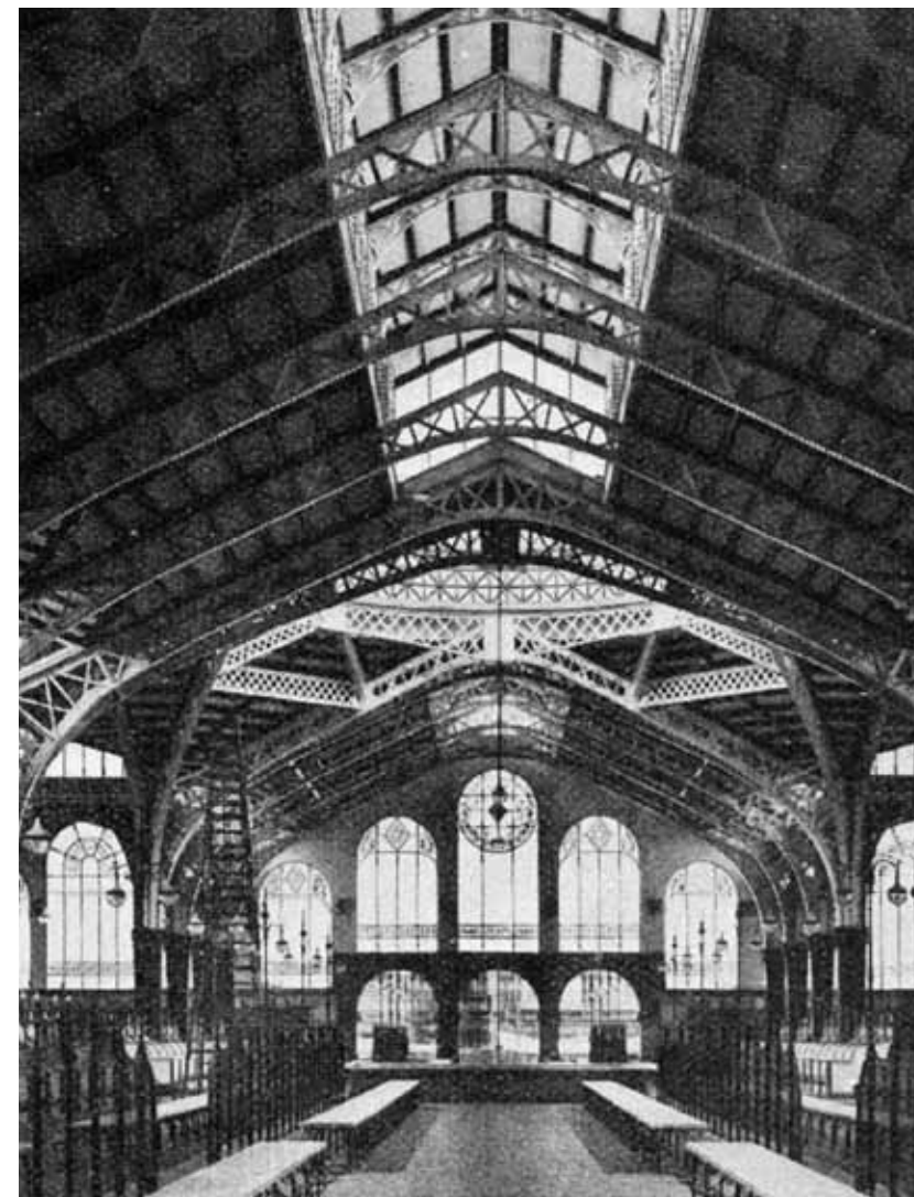
Mercat central de València: coberta amb estructura metàl·lica calculada per Torras Guardiola i realitzada al seus tallers. Principis del segle XX
