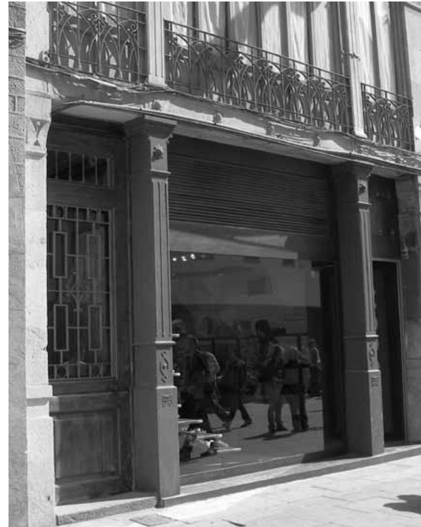
Pilars de fosa a la façana d'un edifici al carrer dels Arcs, districte de Ciutat Vella
