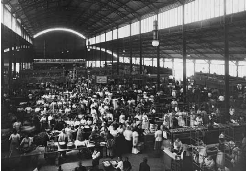
Mercat de l'Abaceria Central a travessera de Gràcia, Barcelona. Projectat i construït per Joan Torras (1893)
