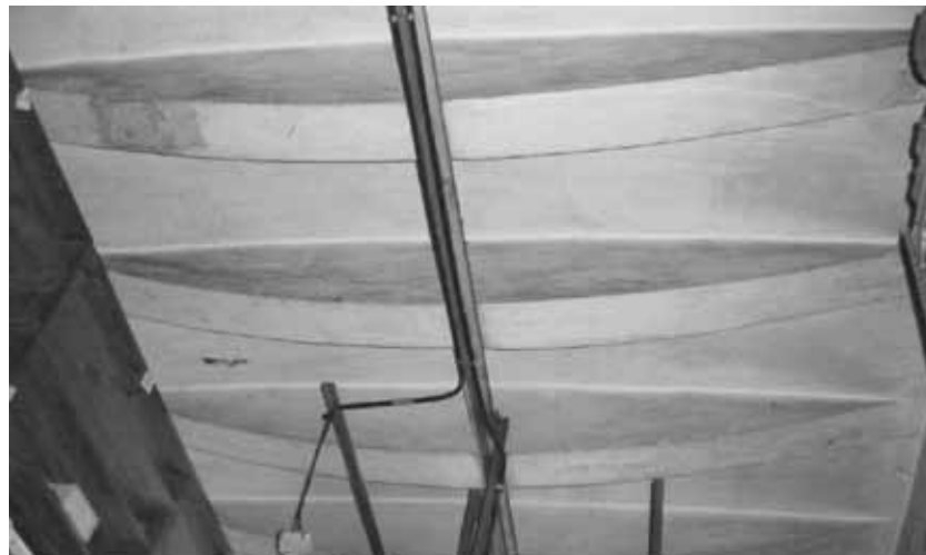
Sostre del soterrani de la casa núm. 74 de la Ronda de Sant Pere amb el sistema de bigues ideat per Torras Guardiola
