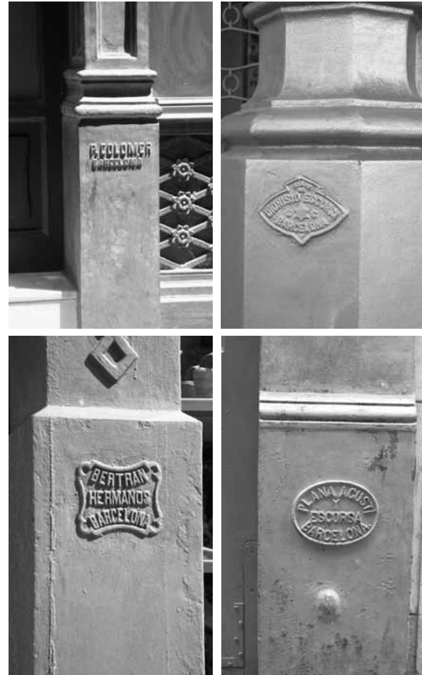
Troncs de pilars amb les plaques de les foneries P. Colomer, Dionisio Escorsa, Bertran Hermanos i Plana Agustí y Escorsa
