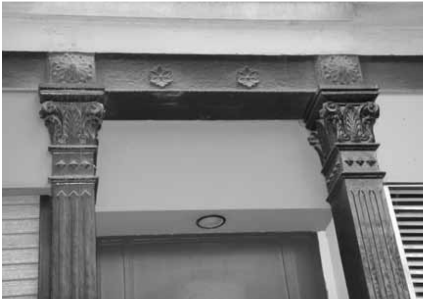
Exemple de pilars amb capitell floral que s'uneixen a una jàssera de ferro
