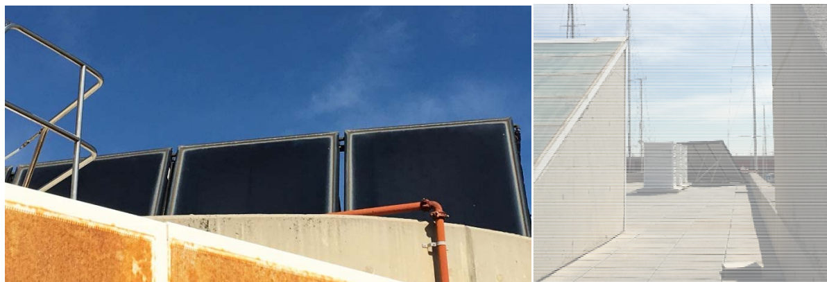
Imatge 109: Sistema solar tèrmic actual a l'edifici de dutxes i bugaderia del PO (a) i superfície lliure (b)
