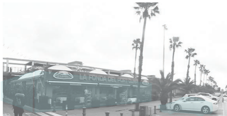
Fotografia actual des de cota port
