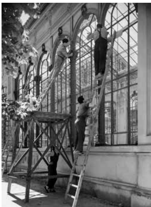
Un grupo de trabajadores de la empresa Cubiertas y Tejados termina la restauración del Invernadero en los años cincuenta.
