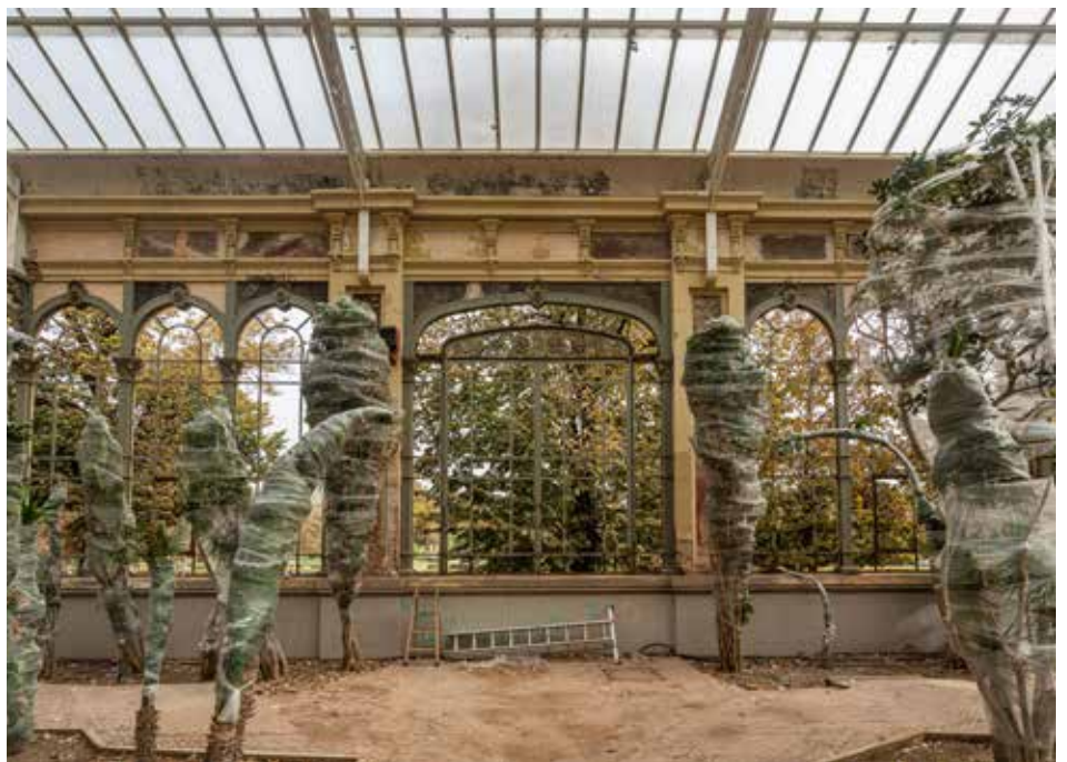
Plantas protegidas en el interior del Invernadero durante la rehabilitación, en octubre del 2022.
