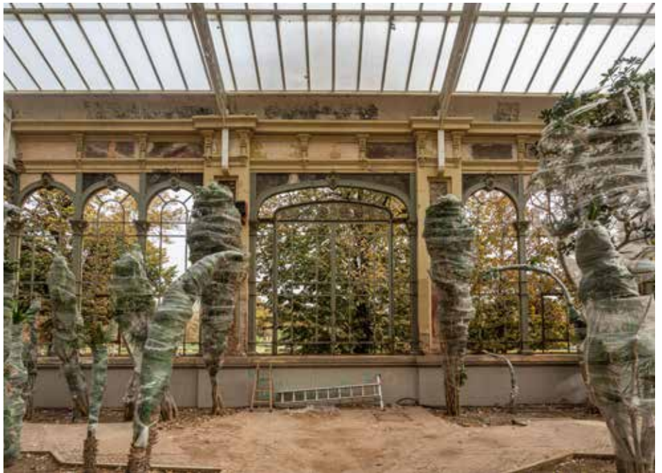
Plantes protegides a l'interior de l'Hivernacle durant la rehabilitació, l'octubre del 2022.
